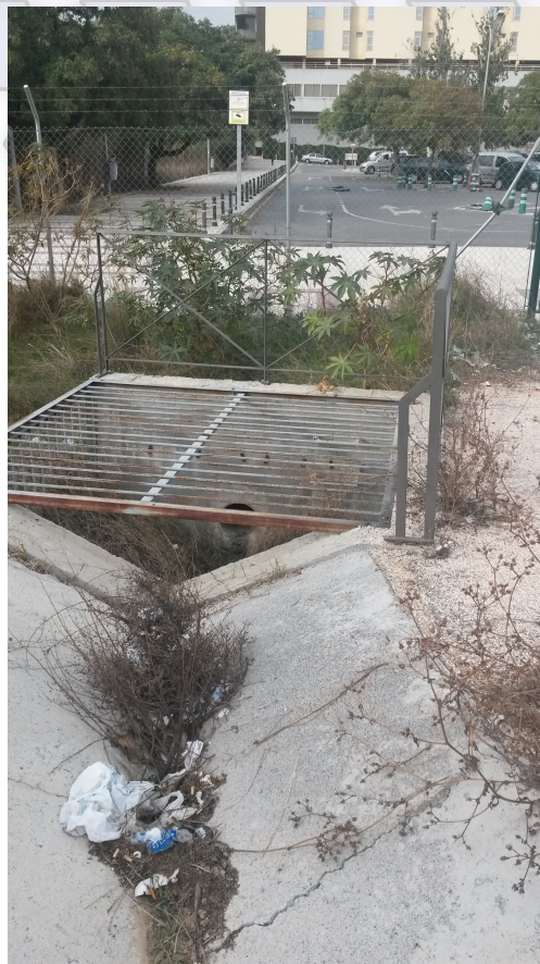
Figura 1.7: Arqueta de drenaje de la plataforma de las vías del metro a demoler, y vista del aparcamiento (firme y acera).
