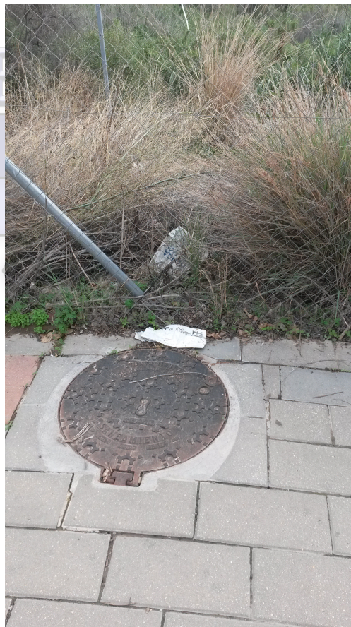
Figura 1.1: Arqueta del colector procedente de la calle Demóstenes.
