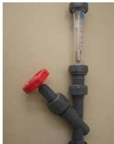
Figura 2. Caudalímetro y válvula de regulación
