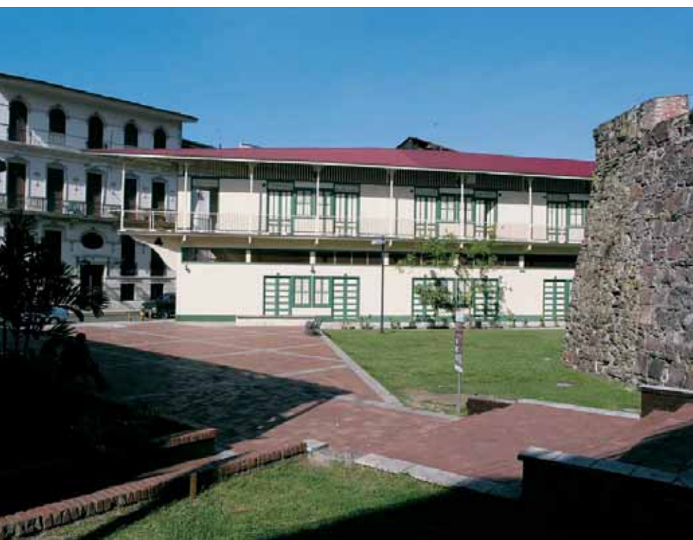
Casa Boyacá en proceso de rehabilitación Imágenes de la rehabilitación concluida
