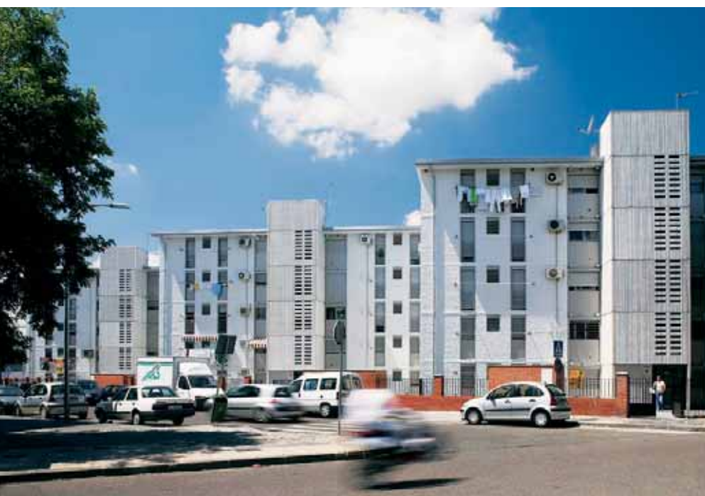
Edificios en San Martín de Porres. Estado previo
