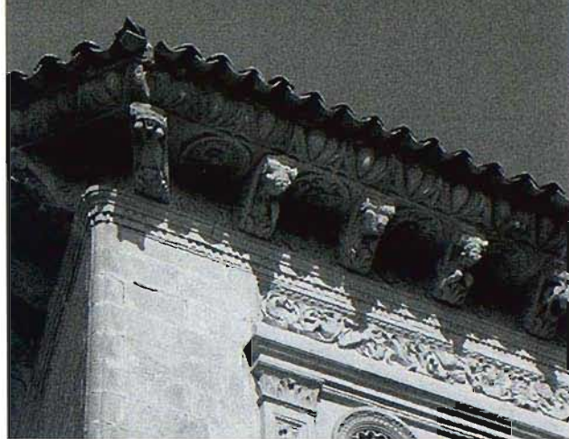
Detalle de la cornisa de la crujía histórica
