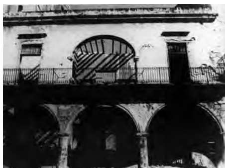
La fachada antes de la restauración
