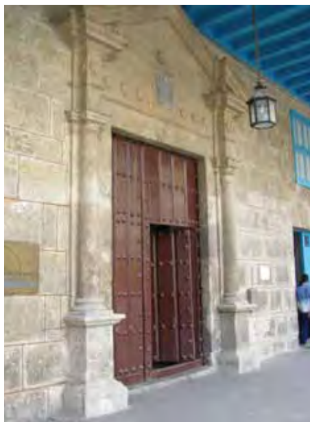
Portada después de la restauración
