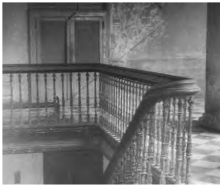
Balaustrada de la casa de las hermanas Cárdenas
