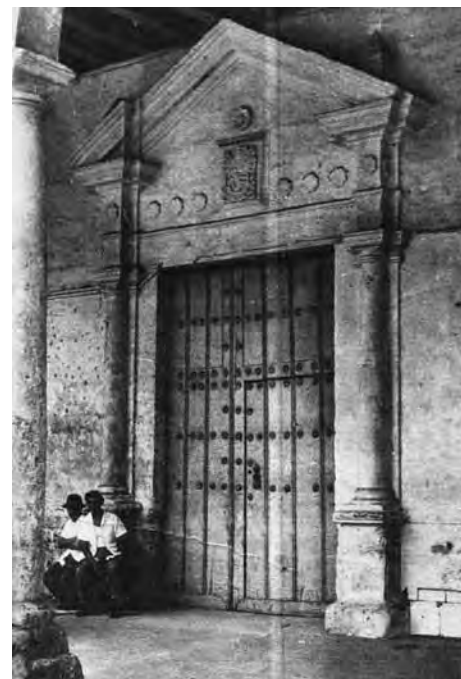
La portada antes de la restauración
