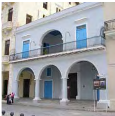
La fachada después de la intervención
