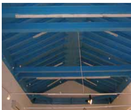
Techo de segunda crujía
