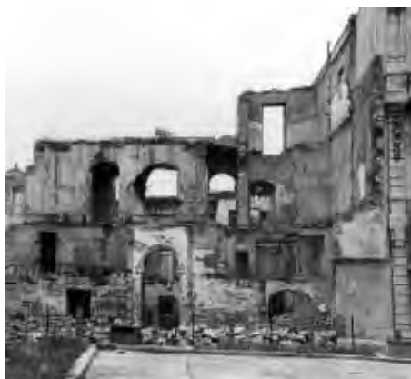
Teniente Rey nº 60 antes y después del derrumbe
