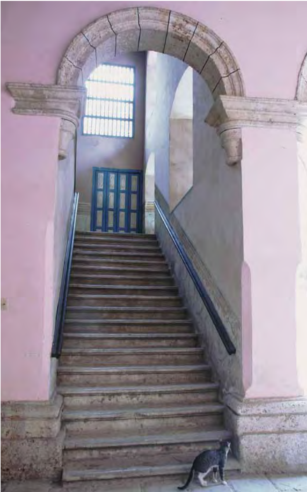
Imagen de la escalera que discurre en paralelo a la galería del patio Página siguiente: vista del patio
