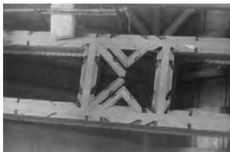
Tirantes antes de la intervención
