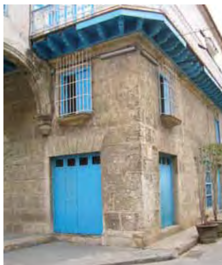
Esquina de Muralla y San Ignacio después de la intervención
