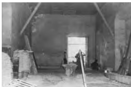
Espacios continuos antes de la intervención constructiva
