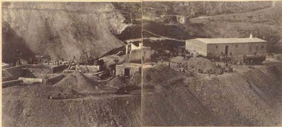
Sierra Almagrera. - Barranco Hospital. La Guzmán. Llegada de la caldera.
