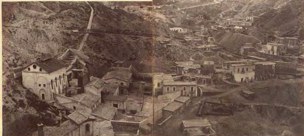
Sierra Almagrera. - Barranco Jaroso. Vista general del desagüe.
