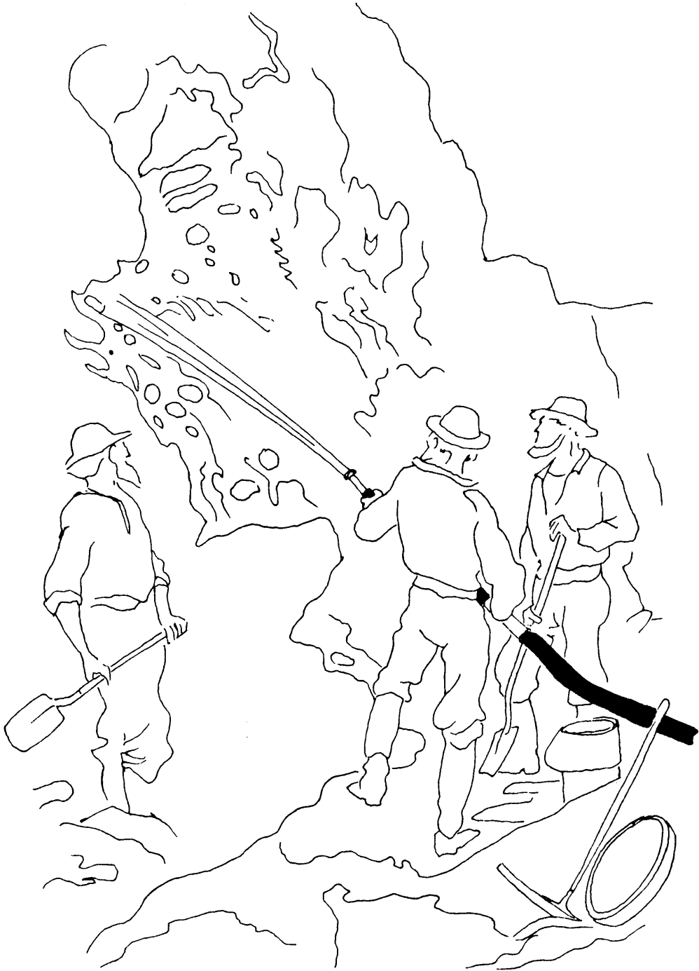
Método hidráulico "californiano", para explotación de los aluviones auríferos.
