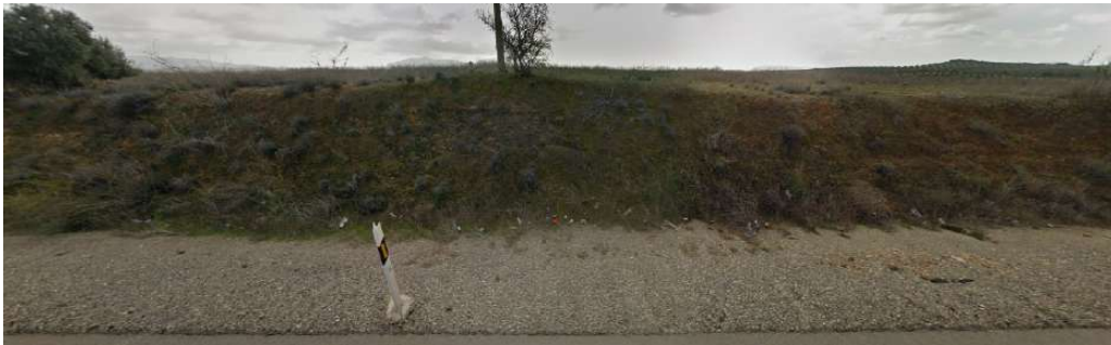
Ilustración 58: Vista hacia los terrenos de la explotación desde la carretera A-384 (sector central).
