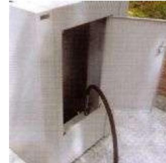
Los sistemas de elevación hidráulicos constituyen un factor de riesgo de proyección de fluido a alta presión por rotura o mal funcionamiento del sistema. Una buena práctica implantada por algunas entidades locales, para la eliminación de este factor de riesgo, es la elevación del contenedor soterrado mediante un sistema hidráulico propio o mediante la incorporación de un motor eléctrico, que es operado por medio de un mando a distancia.
