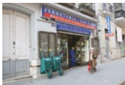
Fachada de la ferretería San Pablo de Sevilla. Foto: Manuel Montilla.
