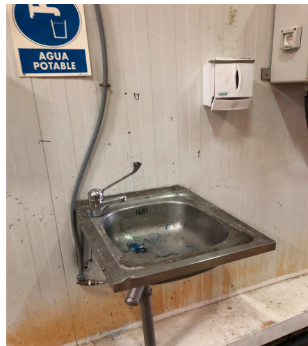
Foto 3. Ejemplos de drenajes y mantenimiento inadecuados
