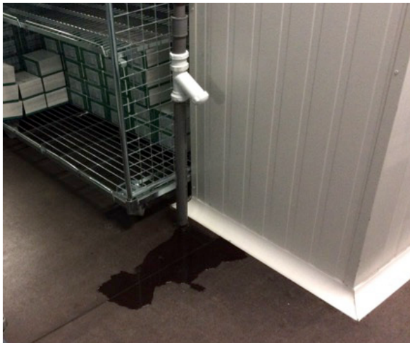
Foto 3. Ejemplos de drenajes y mantenimiento inadecuados
