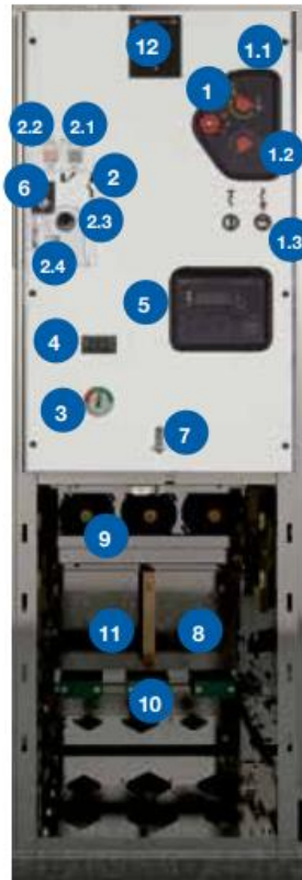
Figura 8. Mecanismos de la celda de línea
