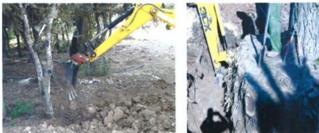
Ilustración 134 Ejemplo de inicio de los trabajos de repicado con retro excavadora.
