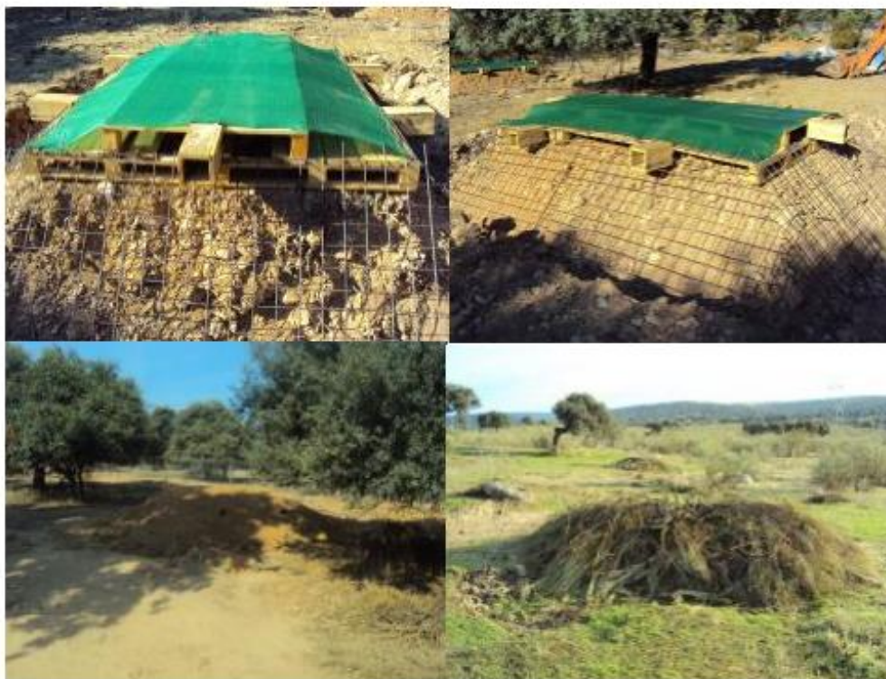
Ilustración 151 Fase de construcción de un majano de pallets de madera
