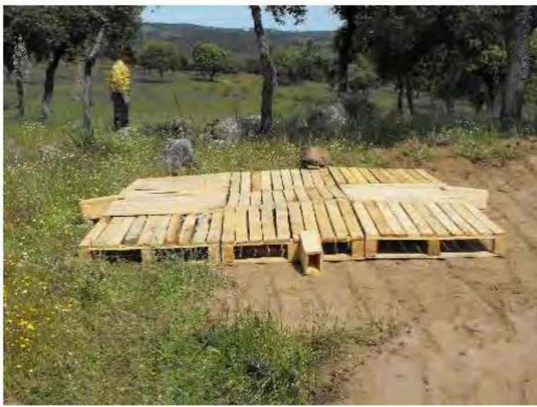
Ilustración 150 Ejemplo de construcción de majanos a partir de pallets de madera
