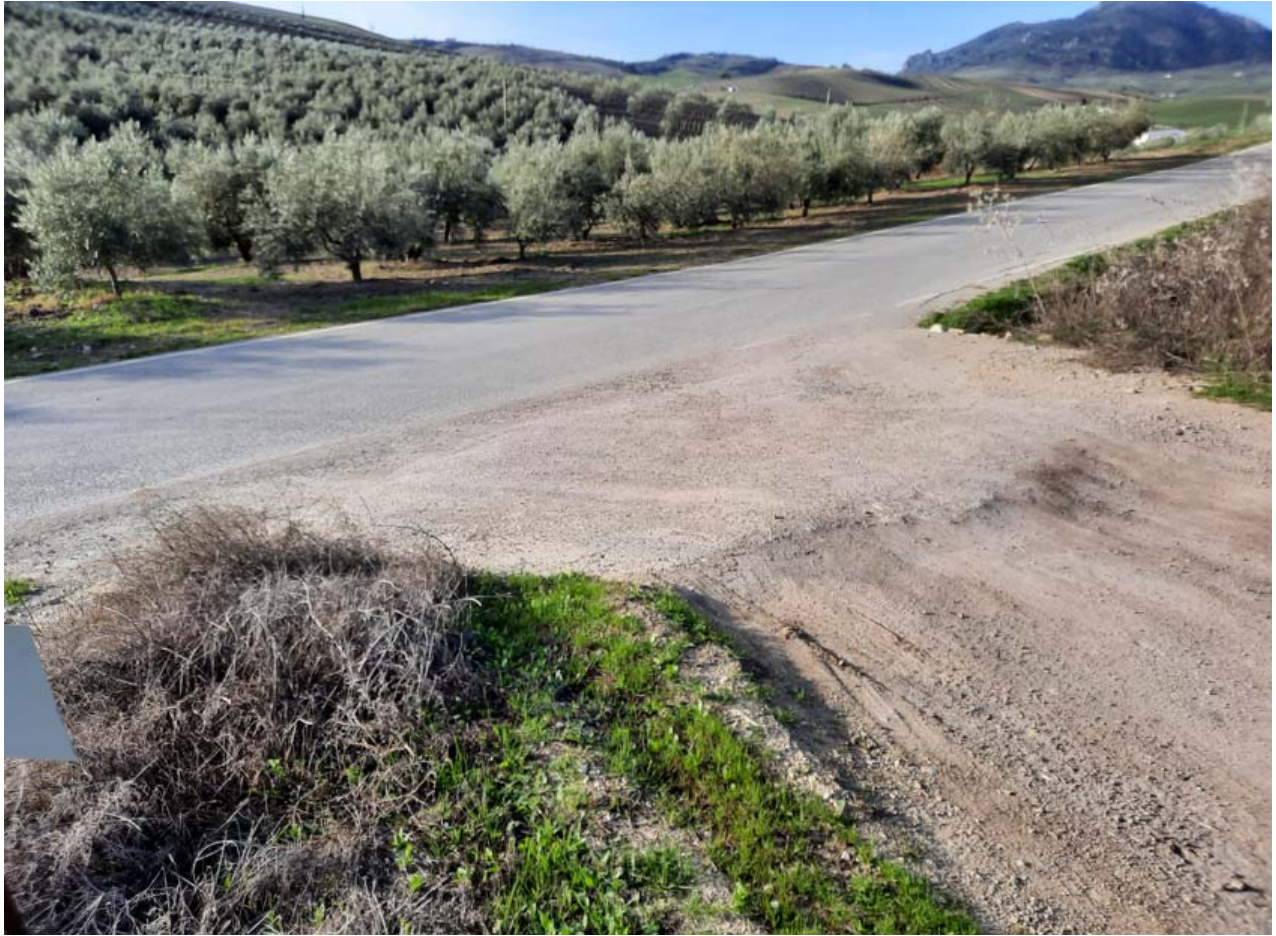
Foto 4.2.: Vista del acceso existente
