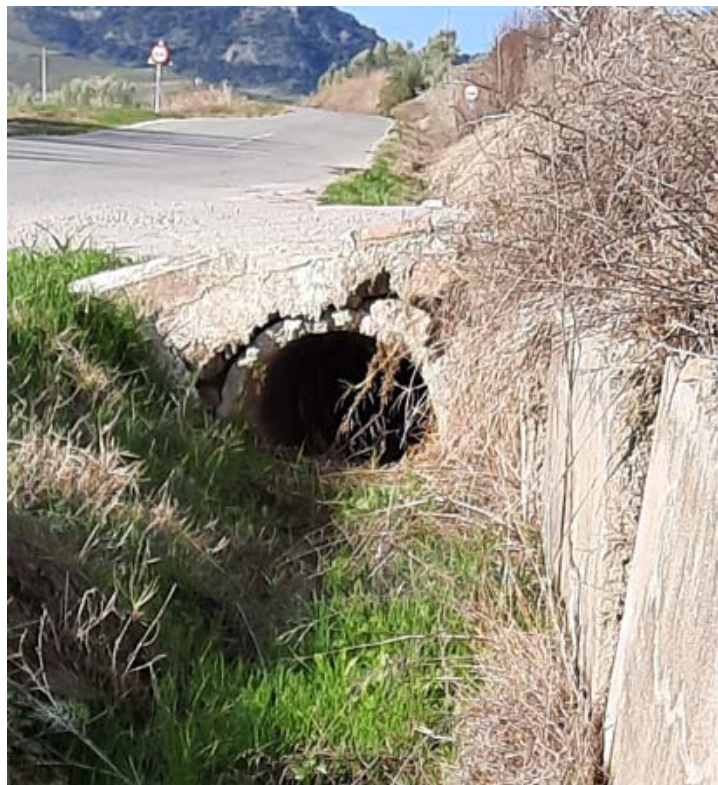
Foto 4.4.: Tubo obra de drenaje transversal al acceso
