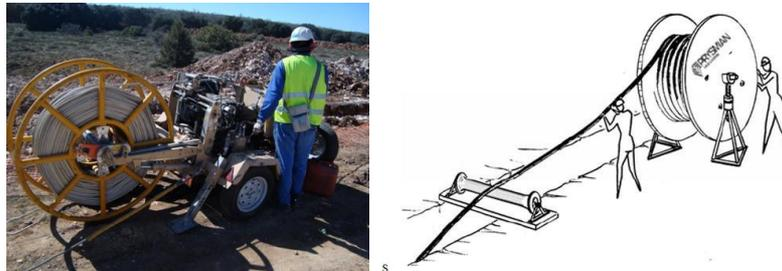
Figura 13. Detalle máquina de tiro y entrada de cable en zanja
