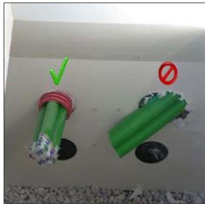
Figura 9. Detalle entrada tubos telecomunicaciones
