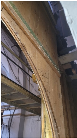
Entablamento reverso y alza de sujeción (Imágenes de inspección).
