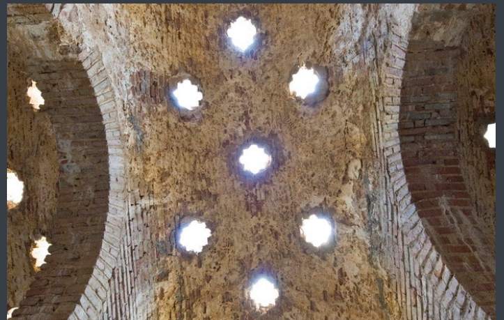
Baños Árabes de Ronda. Vista de una de las bóvedas (Fondo Graáfico IAPH).
