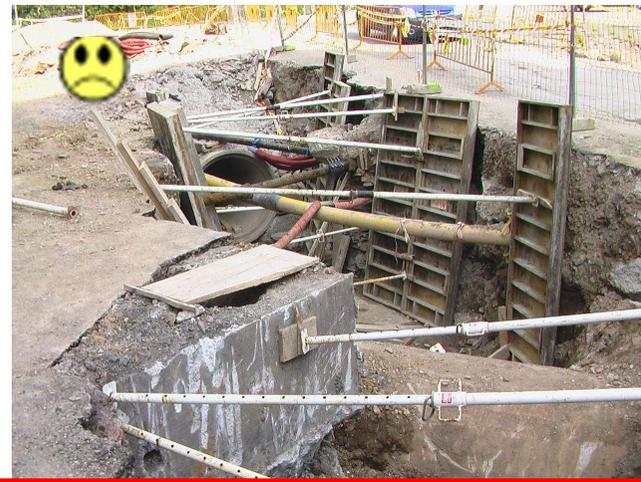
**SISTEMA DE ENTIBACION DE ZANJAS:** Sistema de componentes prefabricados destinados a sostener las paredes verticales de las zanjas, según UNE-EN 13331-1, apartado 3.1.
