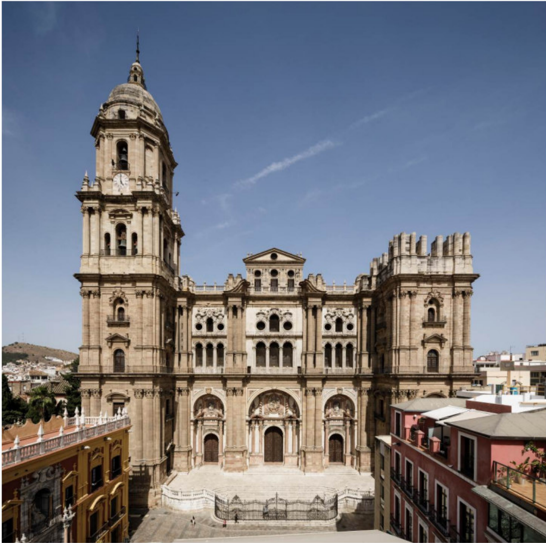
Fig. 16: Fotomontaje de la fachada principal de la catedral de Málaga con el frontón propuesto.
