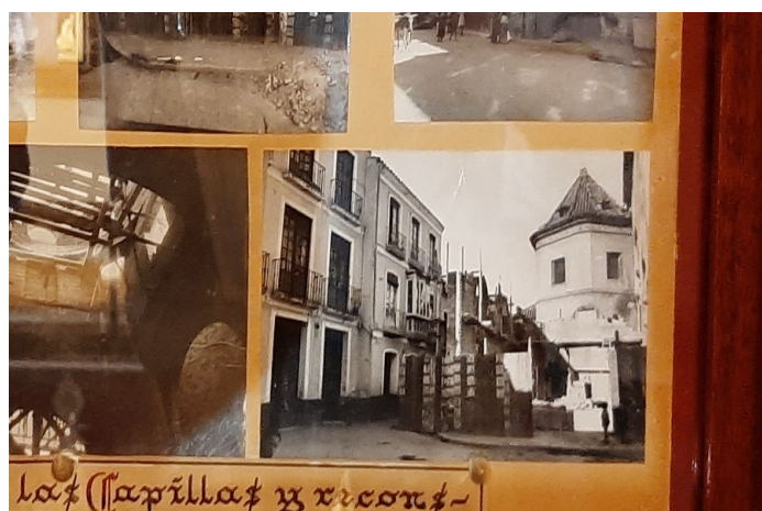
Imagen de las obras de construcción de las capillas del Santísimo Cristo de la Expiración y Nuestra Señora de los Dolores entre 1943 y 1945, donde se aprecia el volumen original de la capilla del Sagrario. (Fuente: Cofradía de la Expiración).
