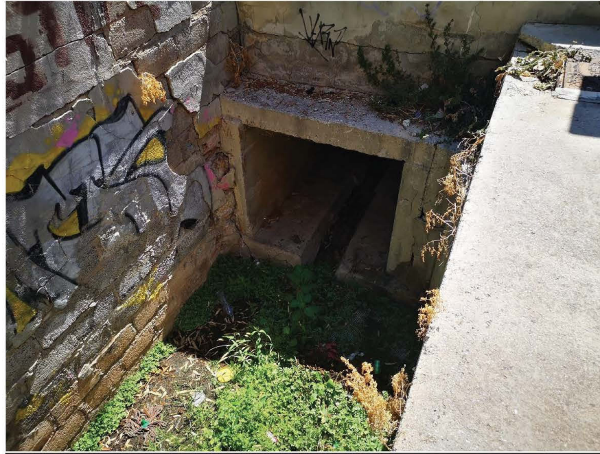
Ilustración 17. Entrada encauzamiento del afluente
