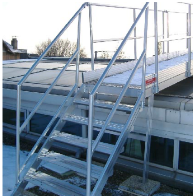
Figura 37. Pasarelas y Plataformas fijas de seguridad (Fuente: Lifting Solutions Group, 2022)
