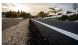
En la renovación del firme se usó polvo de neumático
