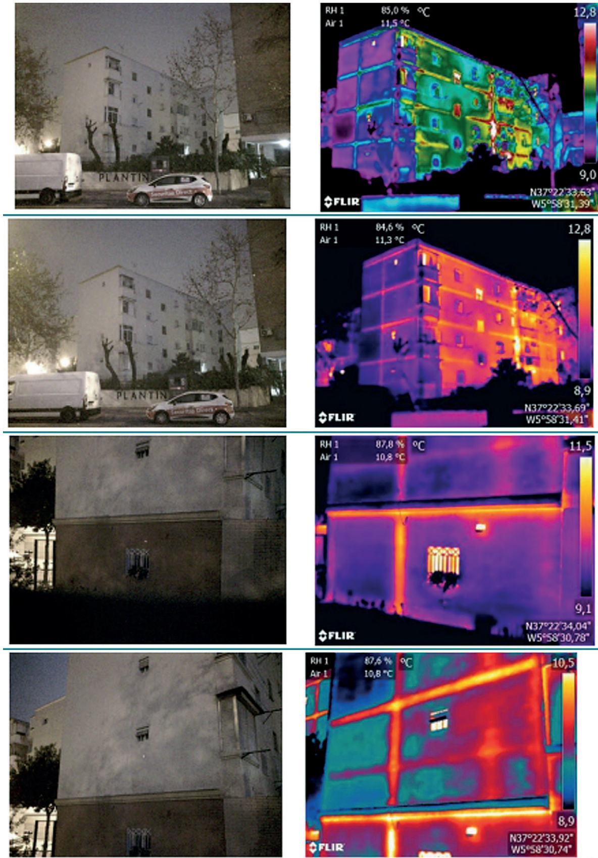
Figura 8.3. Termogramas tomados durante la inspección
