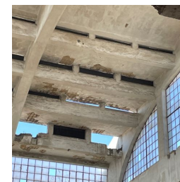
Escalonado estructural cubierta
