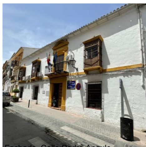
Fachada. Calle Pedro Angulo.
