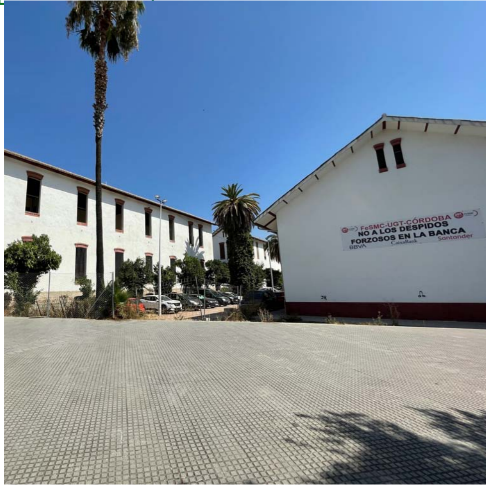
Imagen de acceso al recinto
