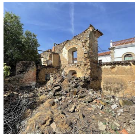
Fachada vista desde el interior
