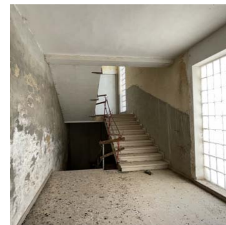
Escalera interior del teatro
