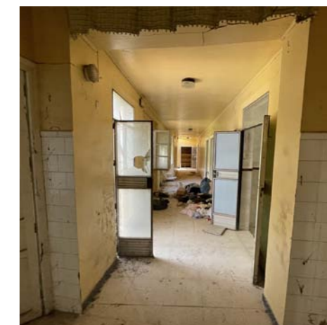
Pasillo de planta primera
