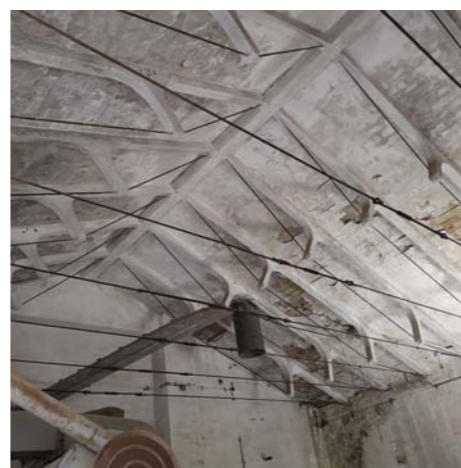
Imagen interior del Silo
