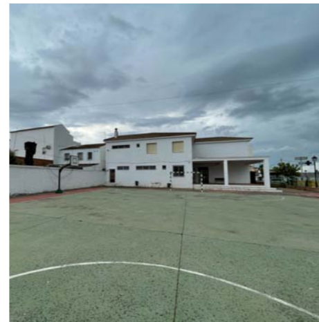
Fachada antiguo colegio público
