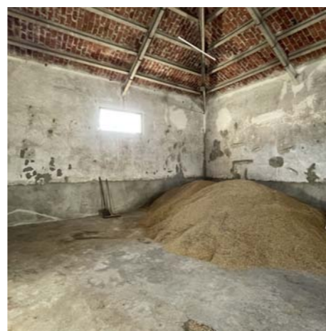
Interior de una de las naves
