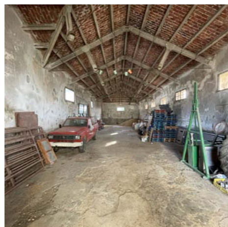
Interior de una de las naves
