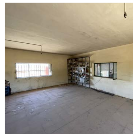
Sala interior planta primera
