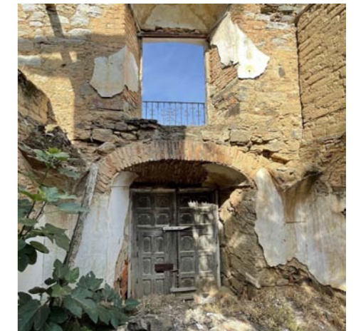
Fachada vista desde el interior
