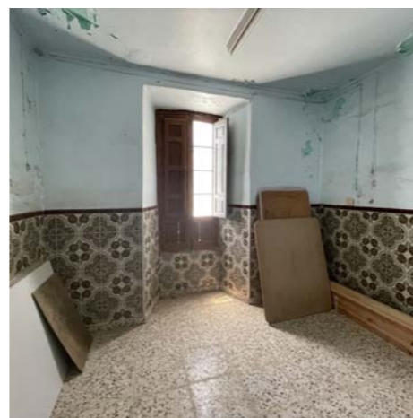
Sala interior de planta baja
