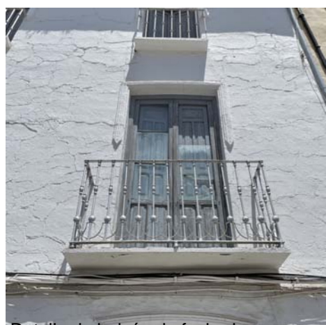
Detalle de balcón de fachada
