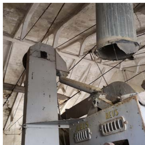
Imagen interior del Silo
