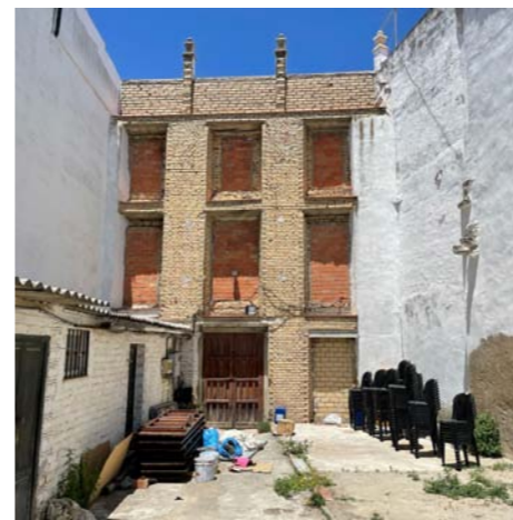
Fachada vista desde el interior
