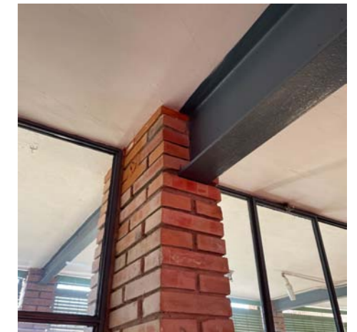
Encuentro entre viga y machón
