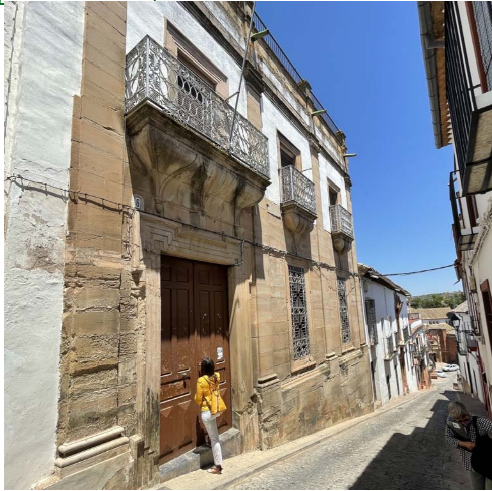
Fachada principal. Calle Salazar.
