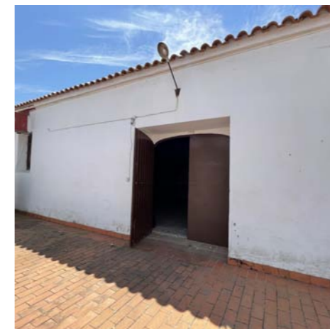
Salida al patio. 1ªNave
