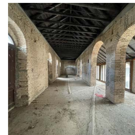
Sala interior sin intervenir.
