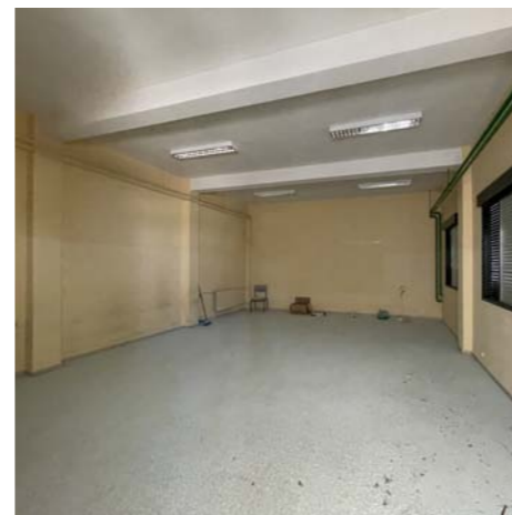
Aula interior de planta primera
