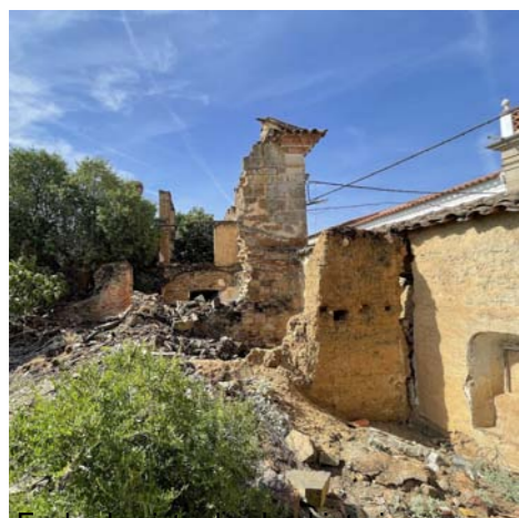
Fachada vista desde el interior
