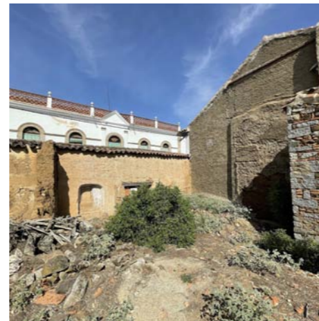
Fachada vista desde el interior
