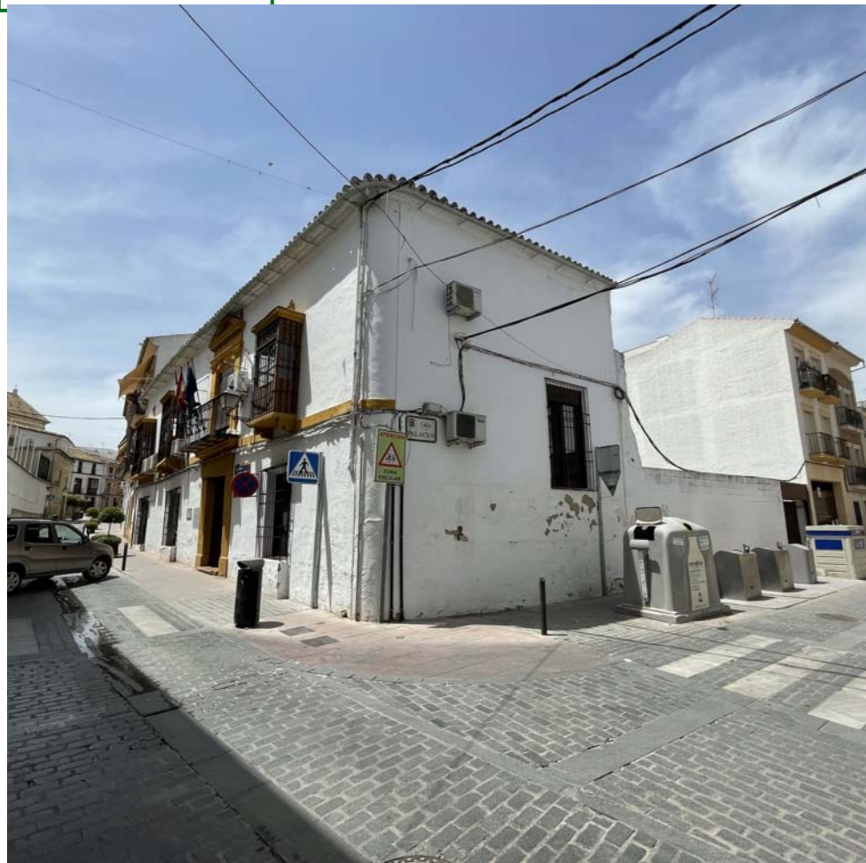
Fachada. Calle Pedro Angulo.
