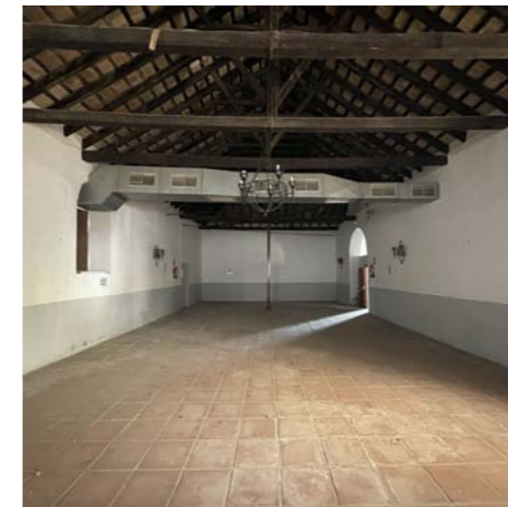
Imagen interior 1ª nave
