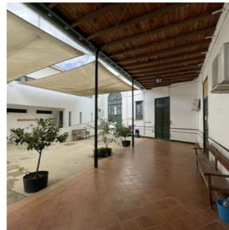
Galería patio interior
