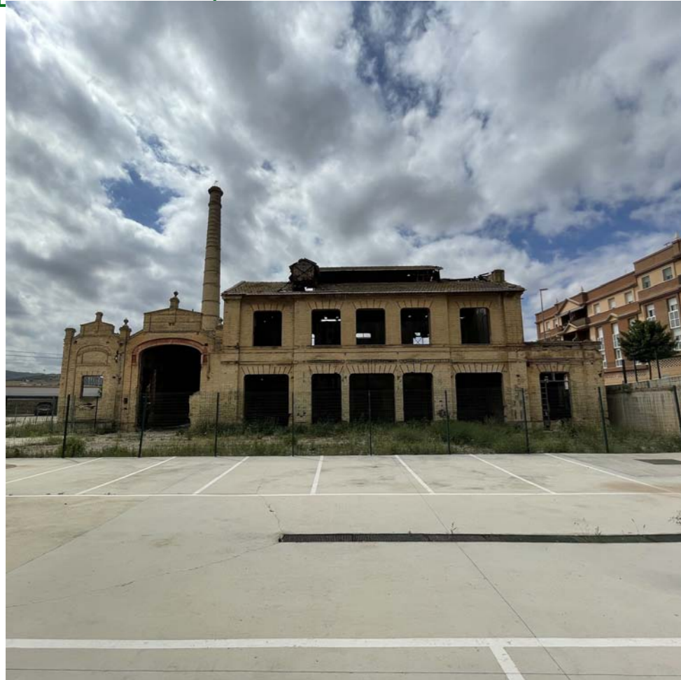
Vista lateral de la Fábrica
