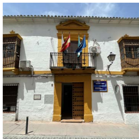
Fachada. Calle Pedro Angulo.
