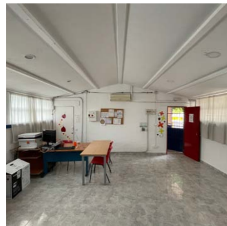
Interior de una de las aulas
