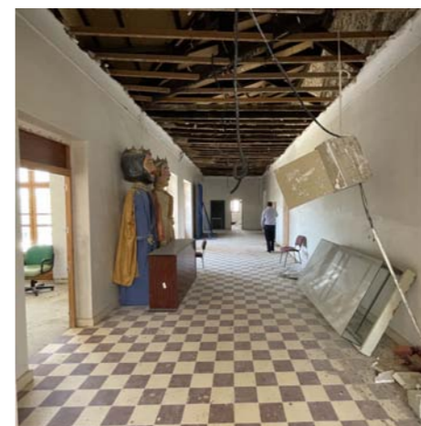
Vestíbulo de planta primera
