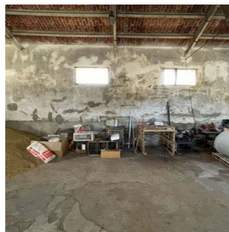
Interior de una de las naves
