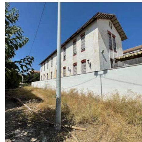
Nave no rehabilitada
