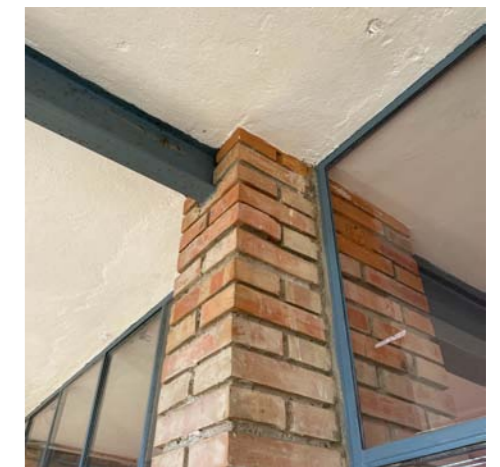
Encuentro de viga y machón
