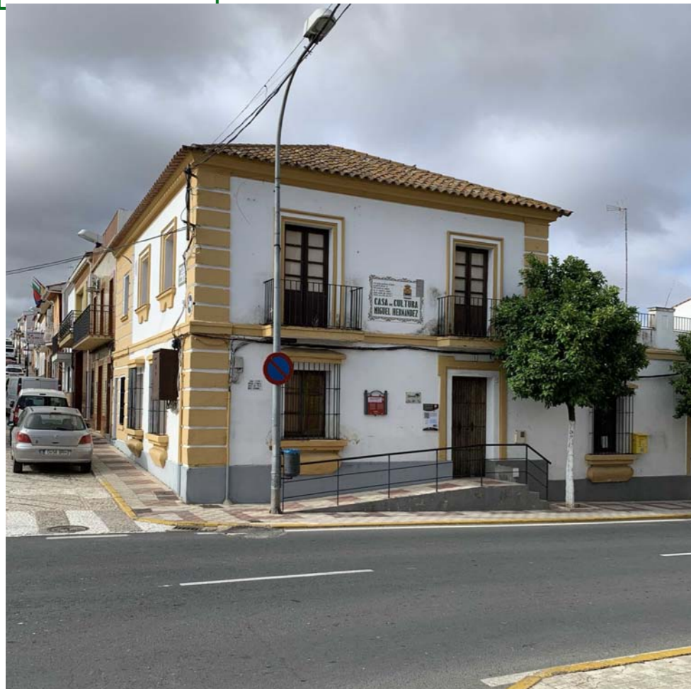
Vista general de la edificación
