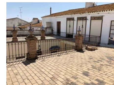
Azotea en planta primera
