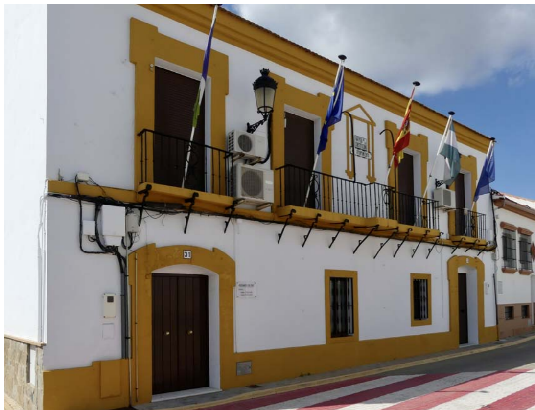
Fachada a la calle Grande
