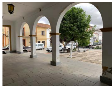
Pórtico de acceso
