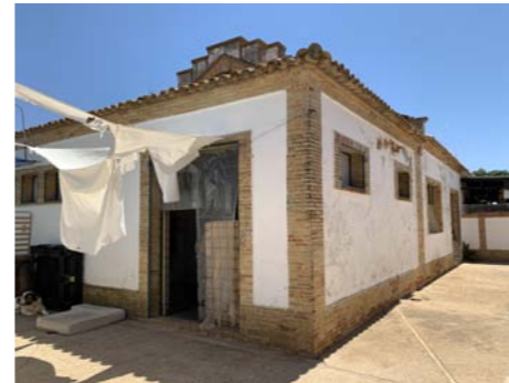
Vista de la edificación central
