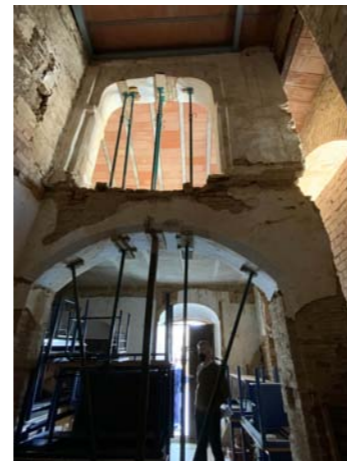
Forjado nuevo y detalle de apeo
