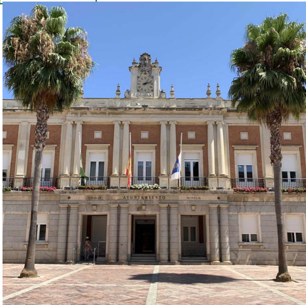
Fachada plaza de la Constitución
