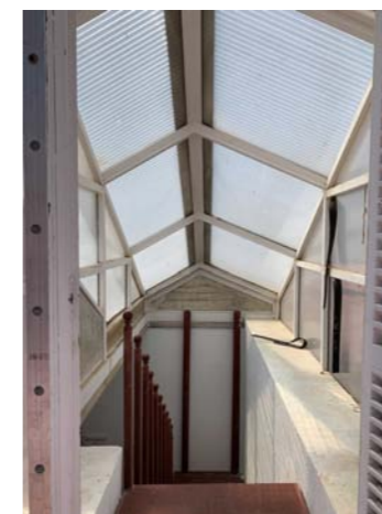
Escalera acceso a cubierta
