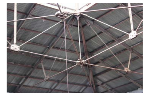
Detalle estructura cubierta
