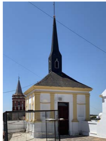
Torreón desde la cubierta
