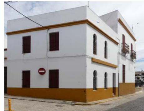
Vista calle San Roque
