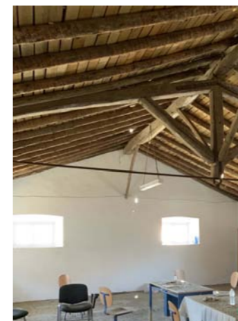
Detalle de la cercha central
