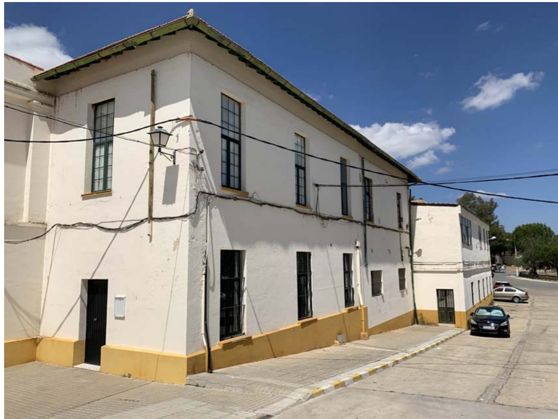
Fachada calle José Nogales
