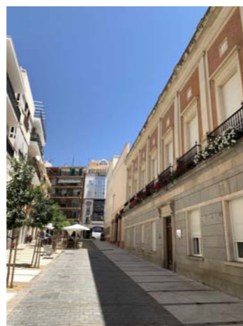
Fachada calle Arcipreste M. G. G.
