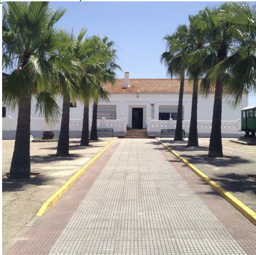
Espacio de acceso al edificio
