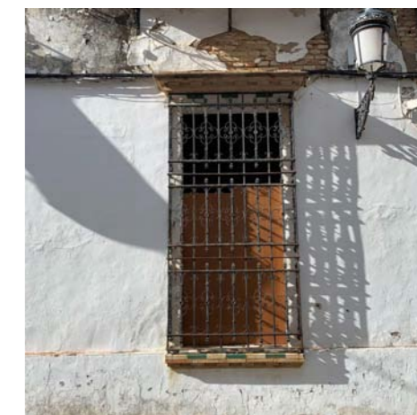
Detalle ventana planta baja
