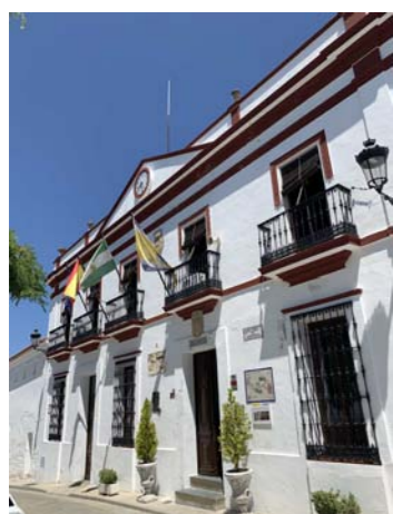
Fachada principal plaza de España
