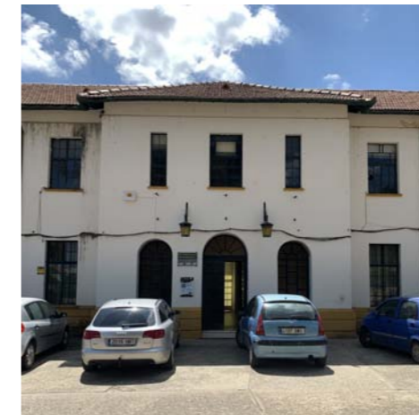
Acceso en fachada principal
