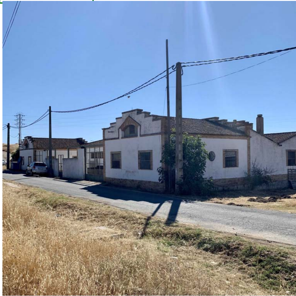
Vista general del conjunto
