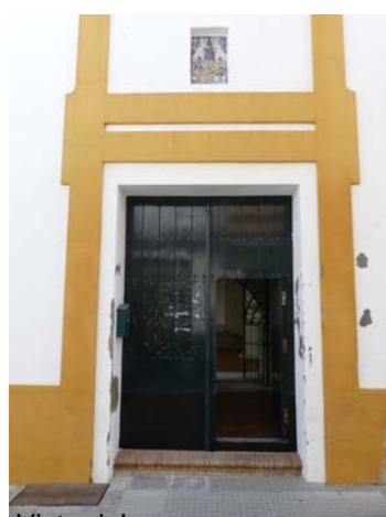
Vista del acceso
