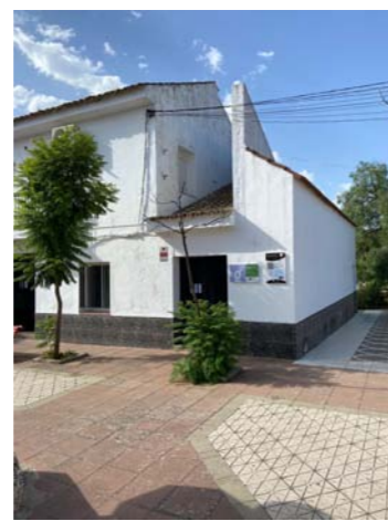
Acceso exterior a planta alta
