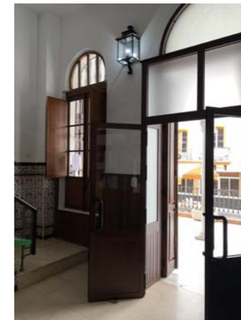
Acceso vista desde el interior
