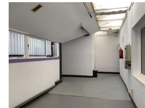
Espacio interior planta segunda
