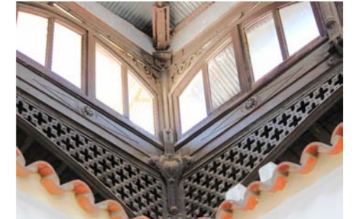
Encuentro carpinterías interior
