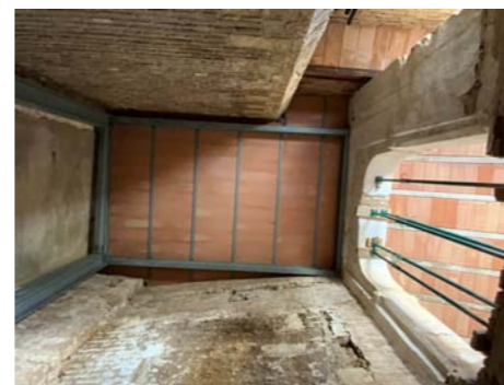
Estado actual del interior
