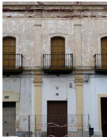
Puerta de acceso calle Convento
