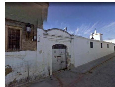
Imagen previa a colocación apeos
