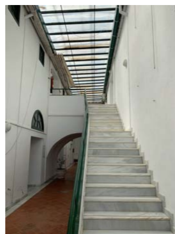
Arranca escalera planta baja
