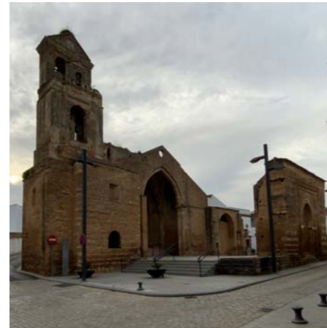
Vista general del conjunto
