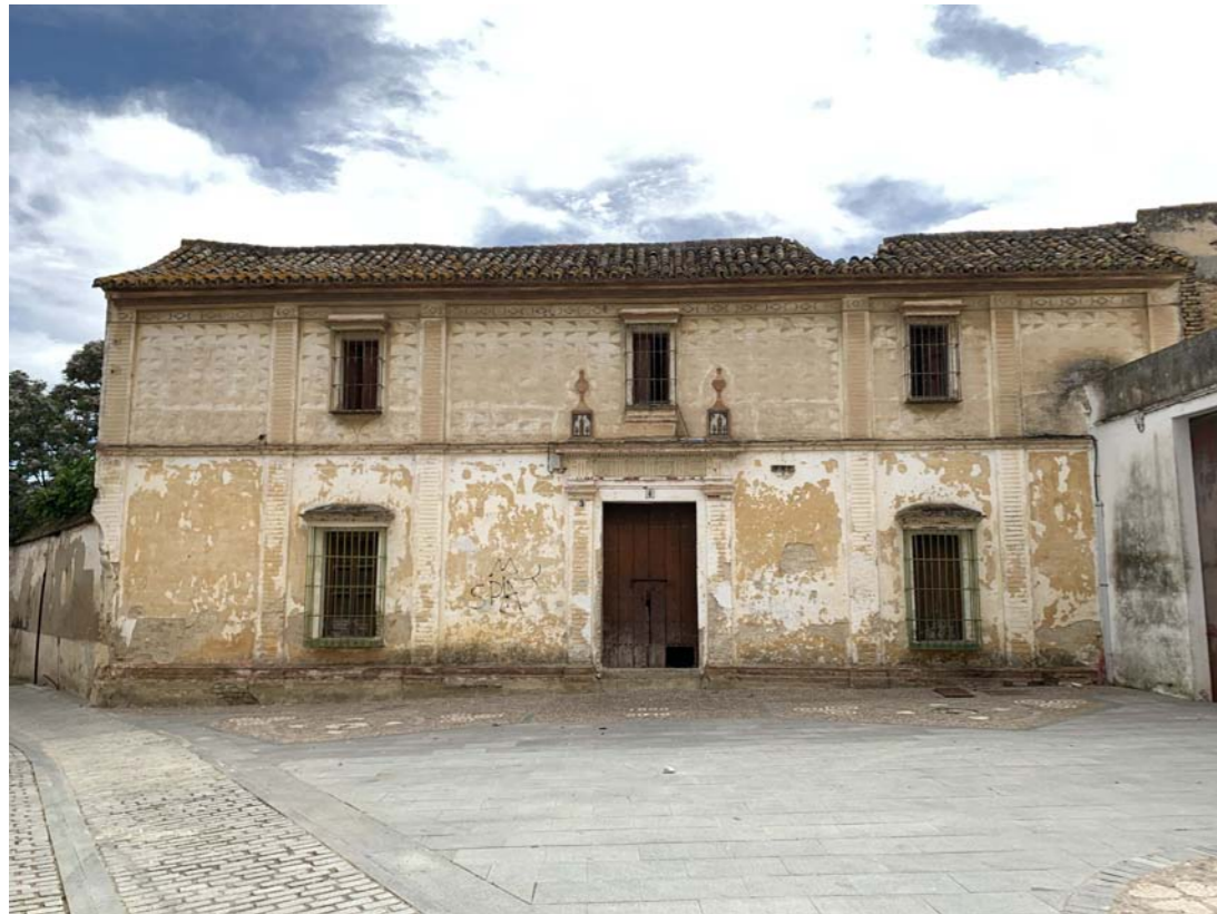
Fachada de la Casa Rectoral
