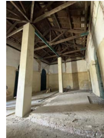
Pilares cuadrados de fábrica
