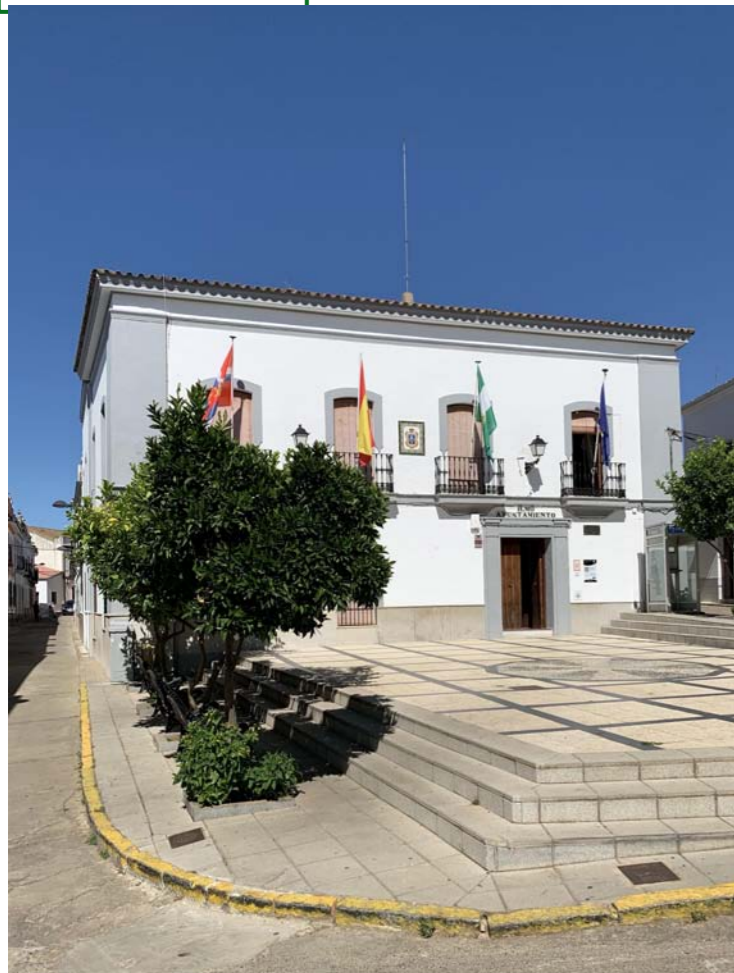
Vista general de la edificación
