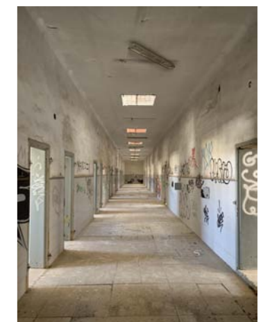
Distribuidor en planta alta
