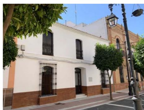
Fachada de la casa adquirida
