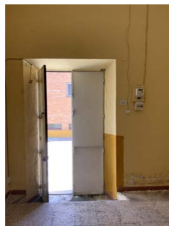
Vista al acceso desde interior
