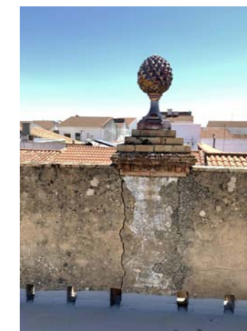
Detalle de pretil en azotea
