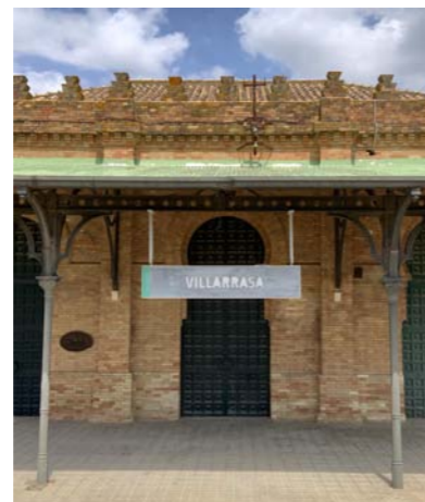
Marquesina metálica sobre pilares
