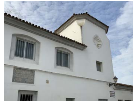
Detalle de fachada principal
