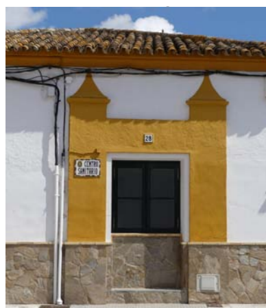
Portada original del edificio
