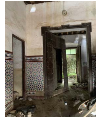
Vista espacio de acceso
