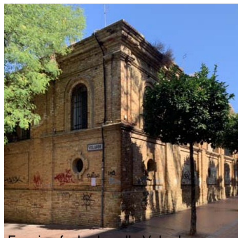
Esquina fachada calle Velarde
