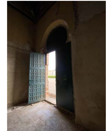
Puerta metálica de acceso
