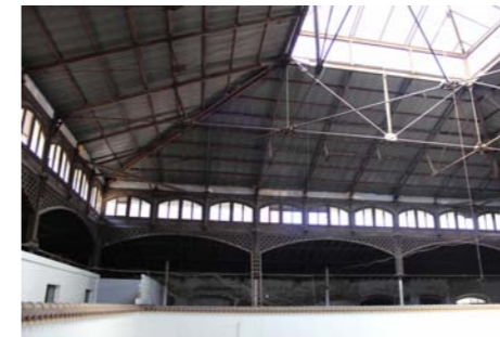
Vista general estructura cubierta
