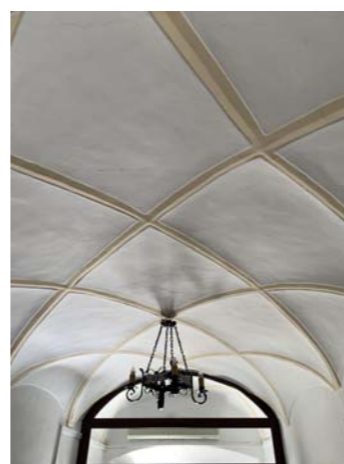
Bóveda tabicada en vestíbulo
