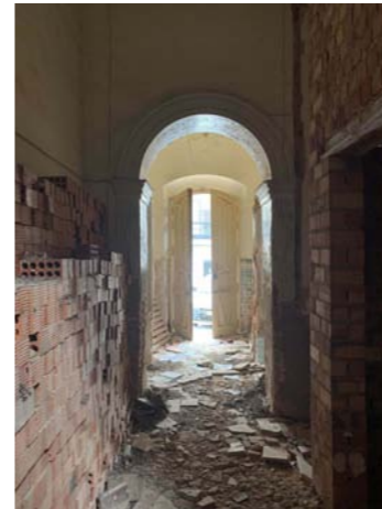
Vista interior hacia acceso
