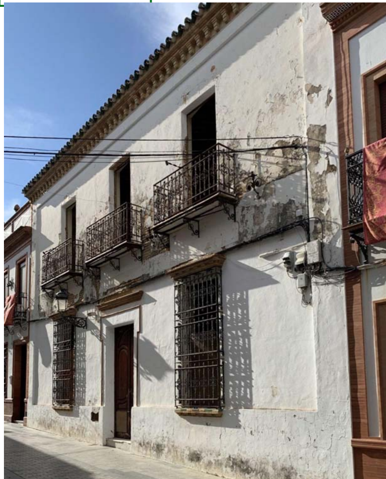
Vista desde calle Antonio Machado
