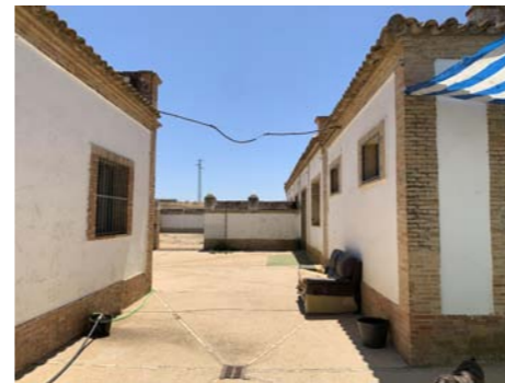
Espacio entre pabellones
