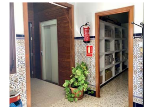
Vestíbulo planta alta
