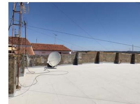
Cubierta plana transitable
