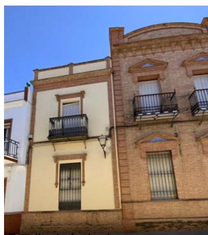
Detalle de fachada
