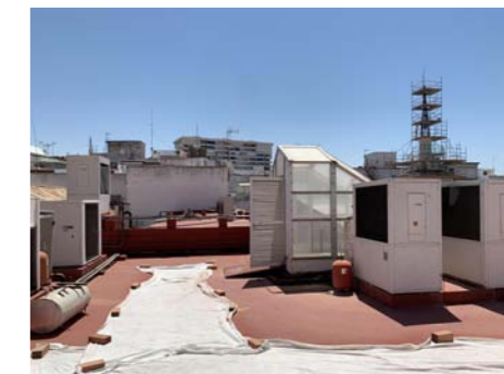
Vista de castillete y cubierta
