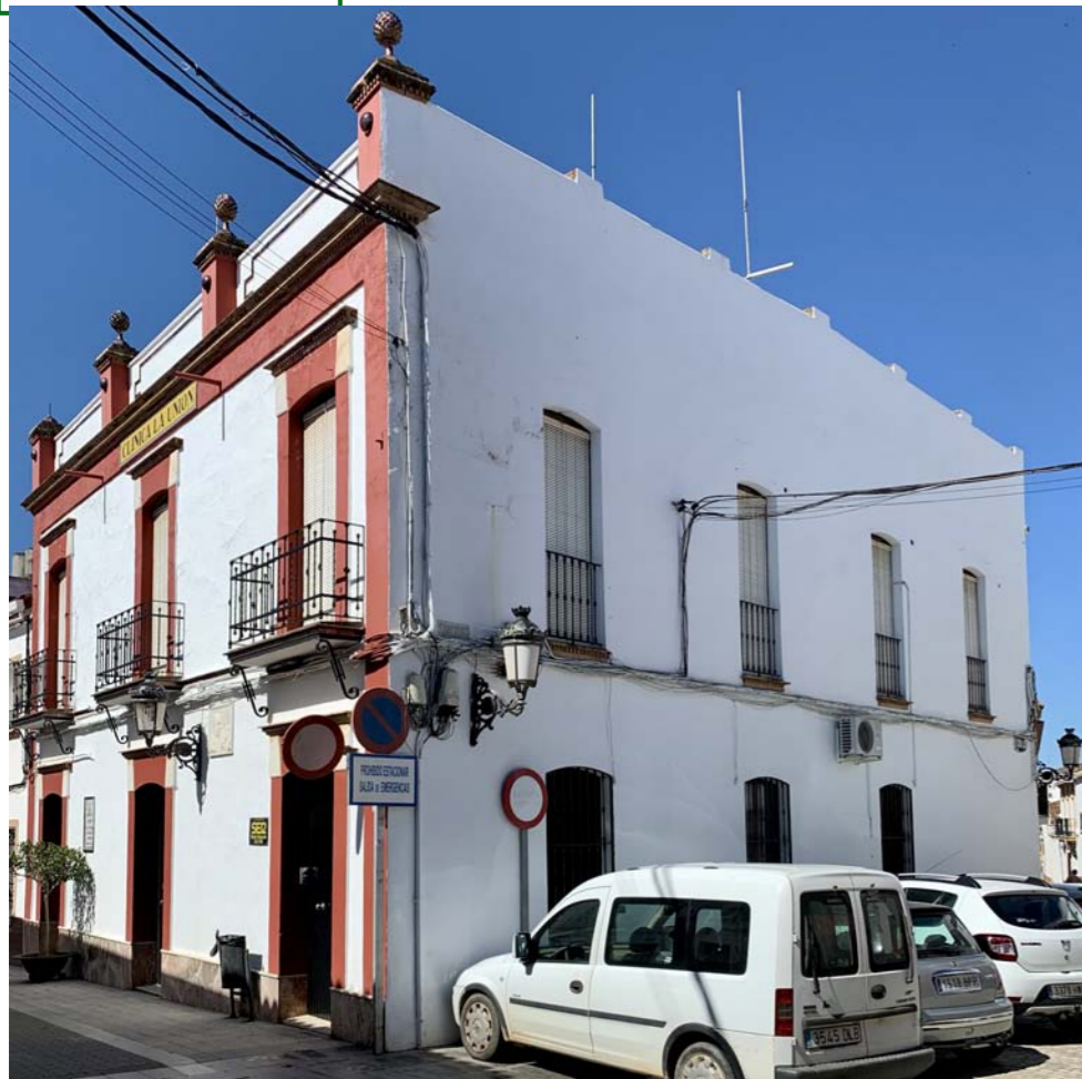
Vista general de la edificación
