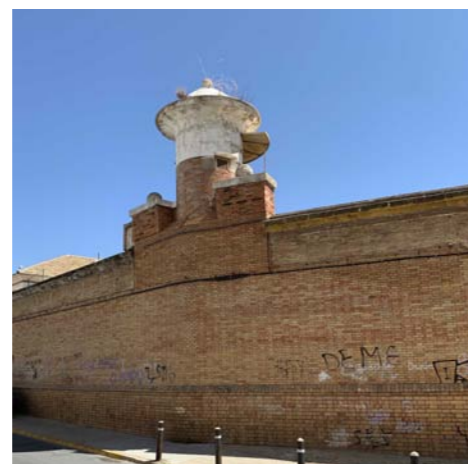
Muro exterior y garita
