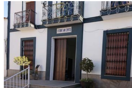
Puerta de entrada al edificio
