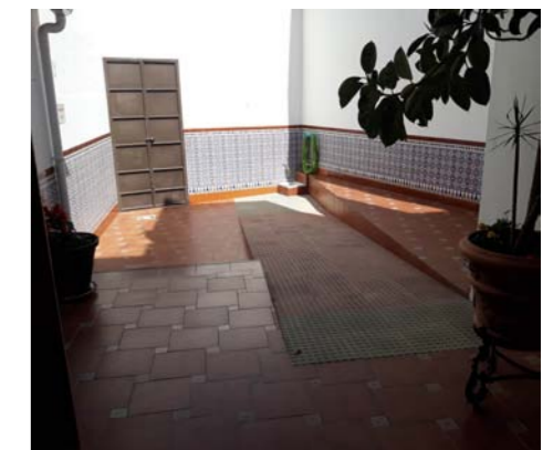
Acceso patio trasero
