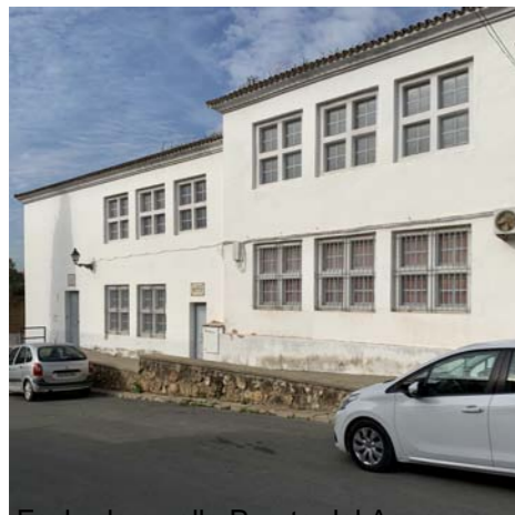
Fachada a calle Puerta del Agua
