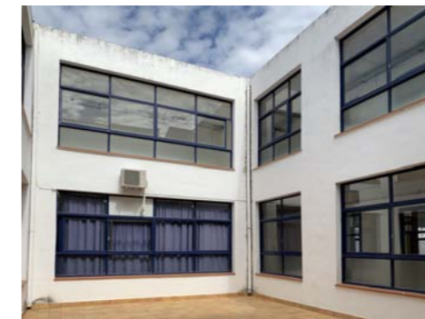
Patio interior oeste
