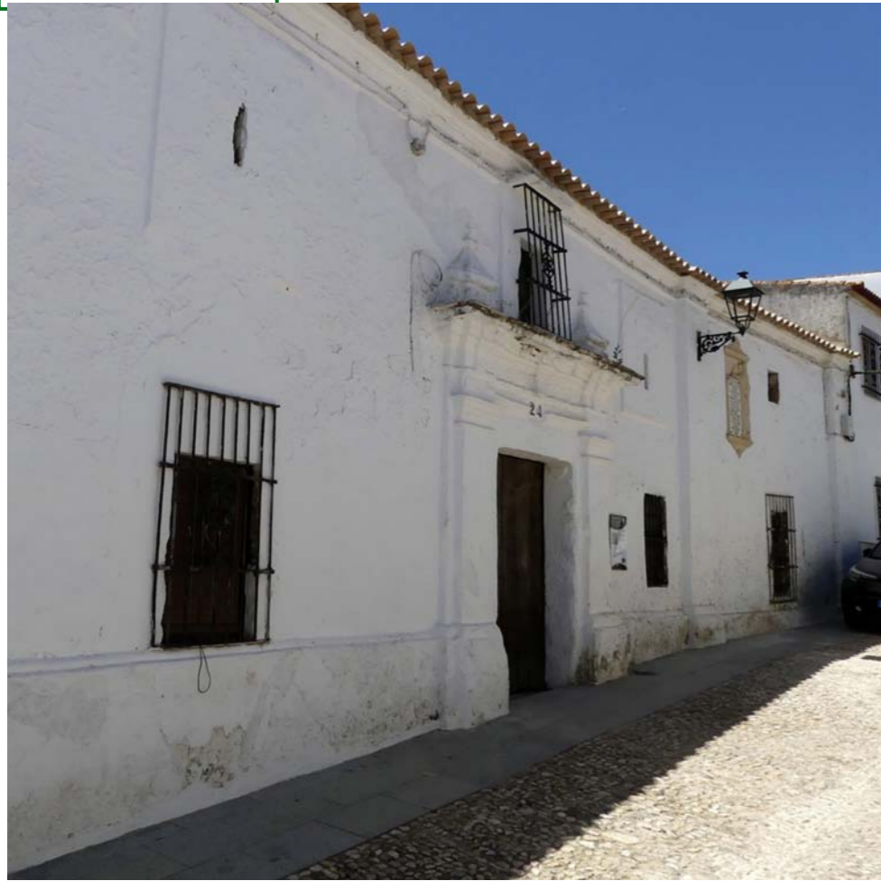
Fachada principal calle Real
