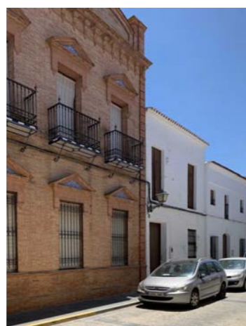
Detalle fachada medianera sur
