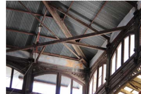
Detalle estructura cubierta
