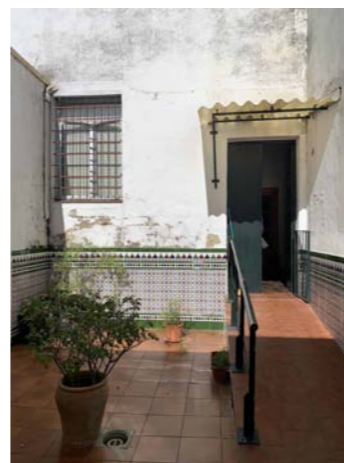
Acceso a patio trasero
