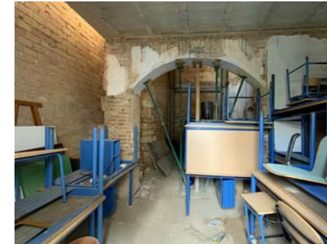
Interior en planta baja
