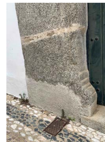
Detalle jamba de granito
