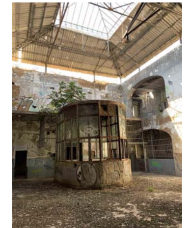
Cubierta metálica en interior
