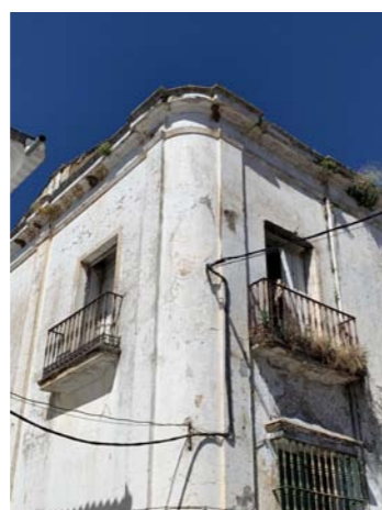
Fachada calle Virgen de Cala
