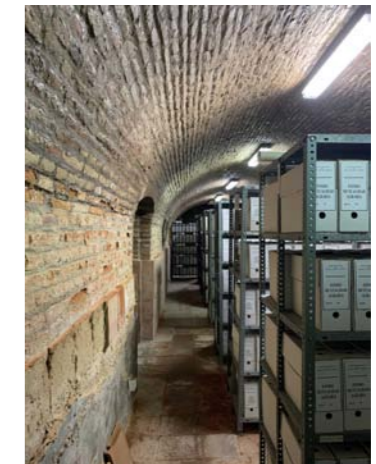
Vista interior del sótano
