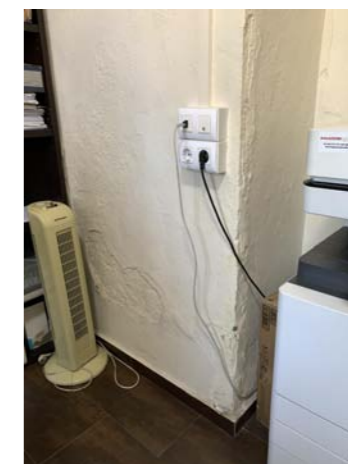
Detalle estado interior
