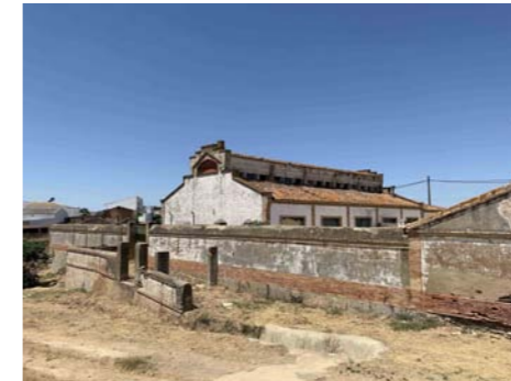
Fachadas traseras desde sureste
