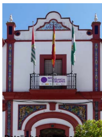
Detalle balcón fachada
