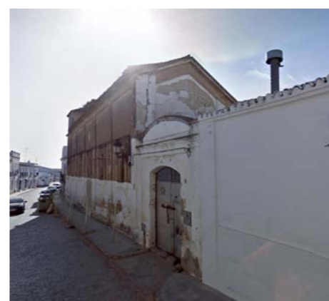
Imagen previa a colocación apeos
