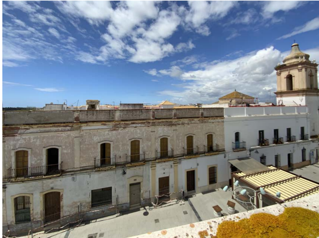
Fachada a calle Convento
