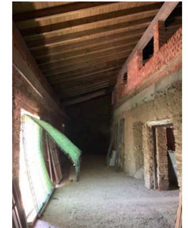
Espacio interior cruj?a al patio
