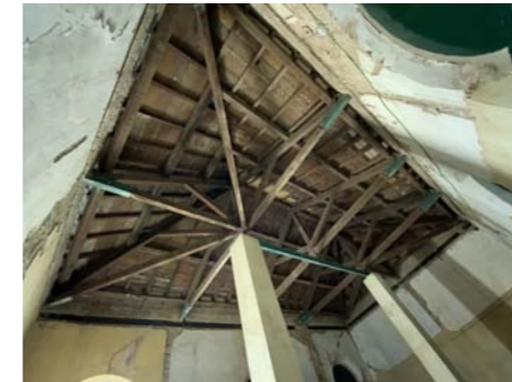
Armadura de madera con cerchas
