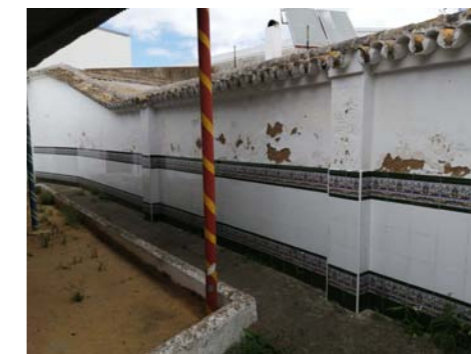
Muro medianero en patio trasero
