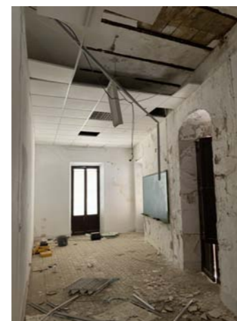
Estructura de forjado de cubierta
