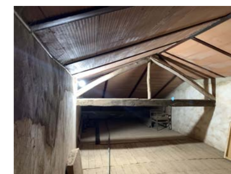
Espacio bajo cubierta
