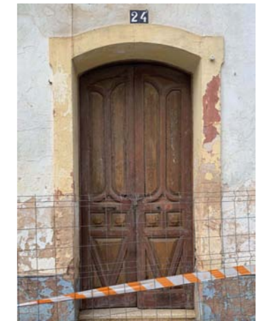
Acceso desde calle Convento
