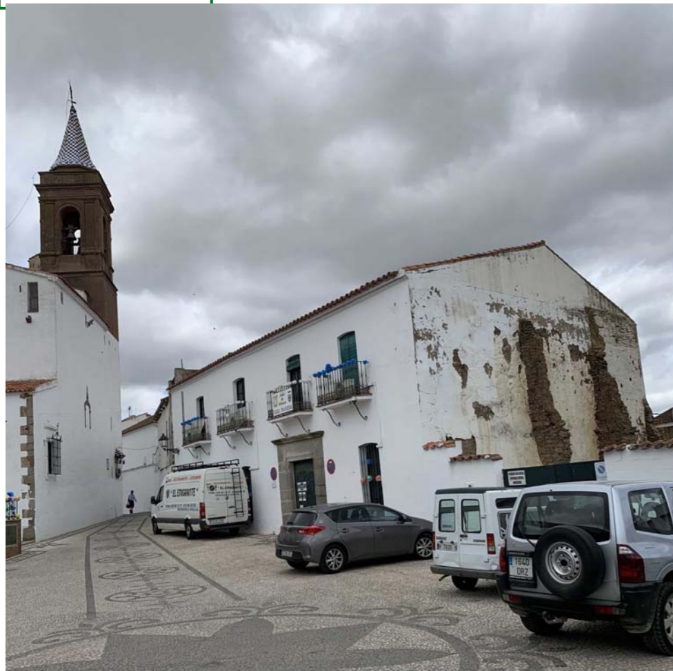
Vista general del conjunto
