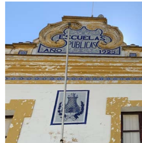
Detalle cabecera fachada
