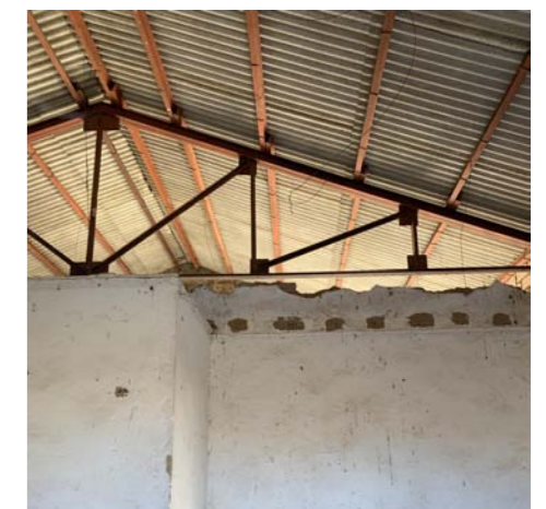
Detalle de la cercha metálica
