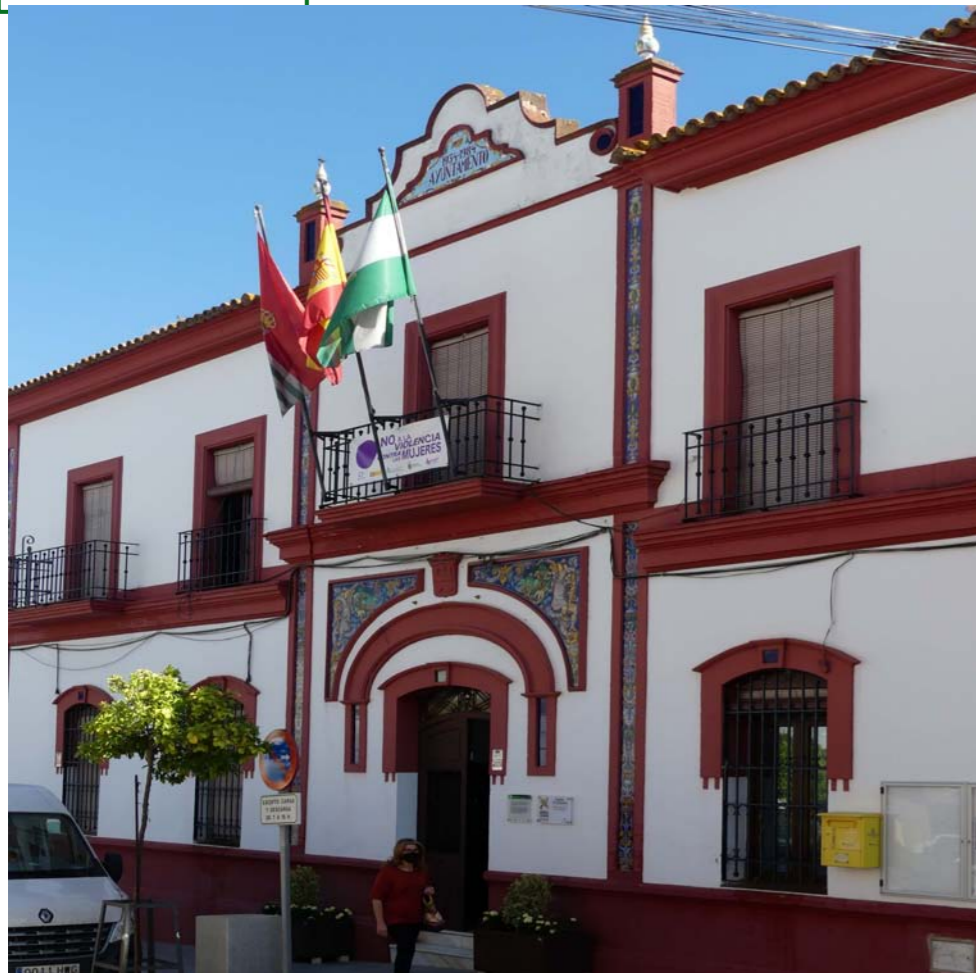
Vista fachada calle Serpa
