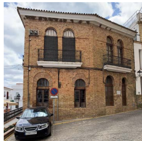
Vista exterior alzado lateral
