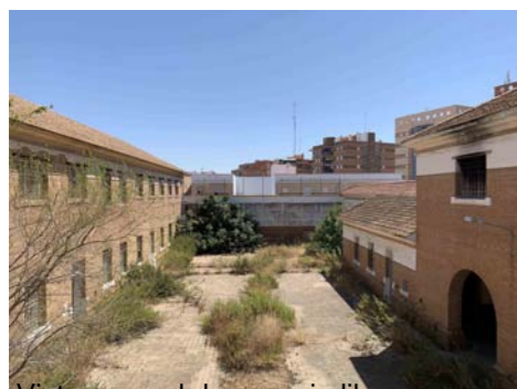
Vista general de espacio libre
