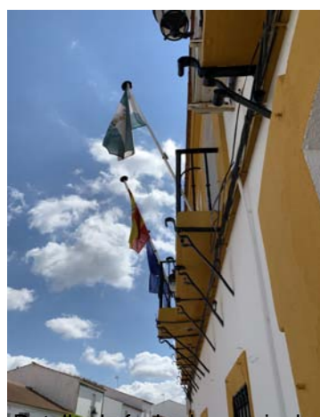
Detalle de fachada principal
