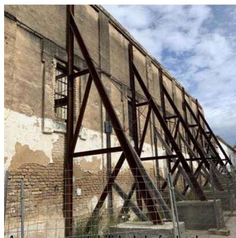
Apeo para estabilidad de fachada
