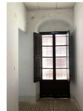
Detalle carpintería planta alta
