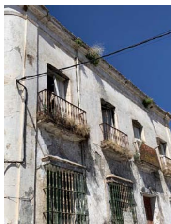
Fachada calle Virgen de Cala
