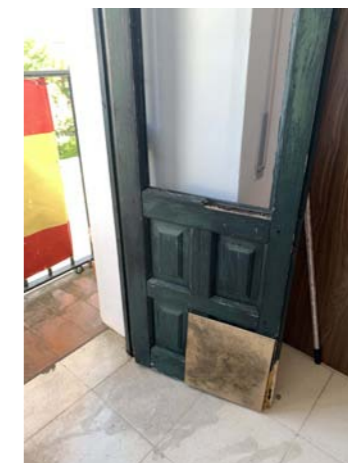
Carpintería del balcón en fachada
