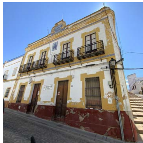
Vista fachada calle Galdames
