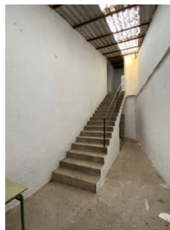
Espacio de acceso a planta alta
