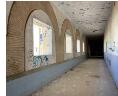
Espacio interior planta baja
