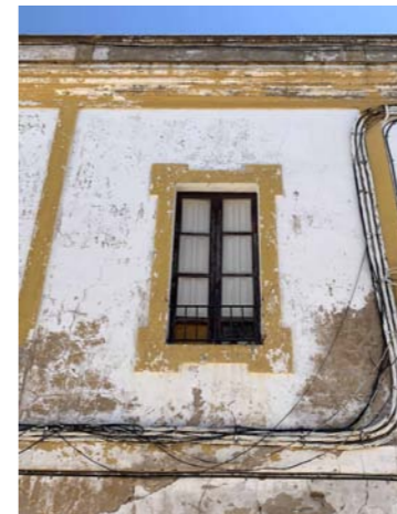
Detalle ventana en planta alta
