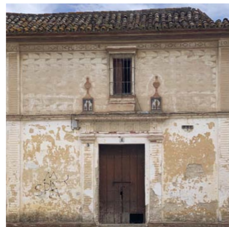
Detalle fachada principal.
