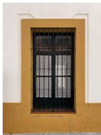
Ventana en planta baja
