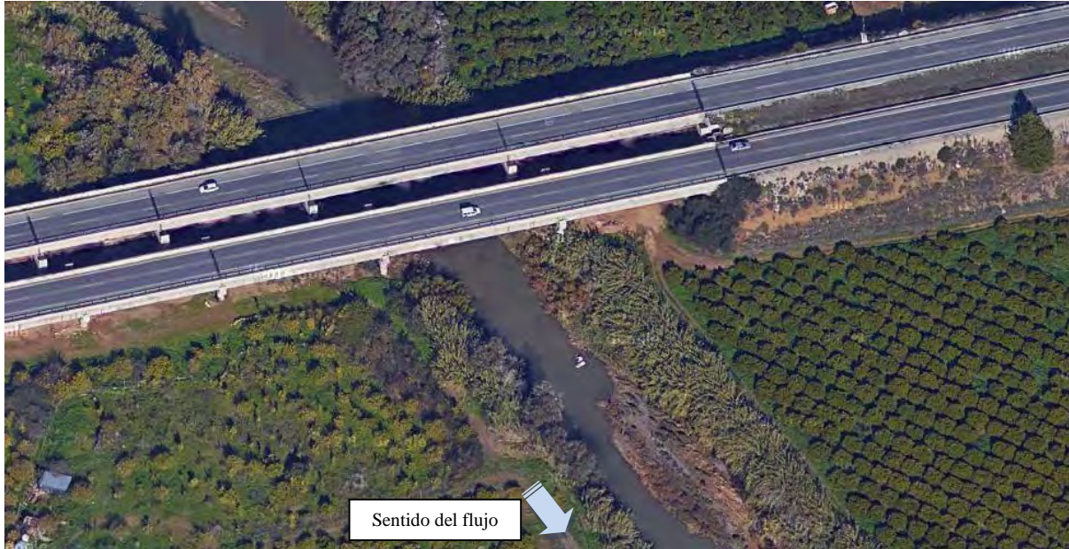
10 Imagen del cauce del río Guadalhorce aguas abajo del puente de la A-357 con llanura de inundación a base de plantación de cítricos
