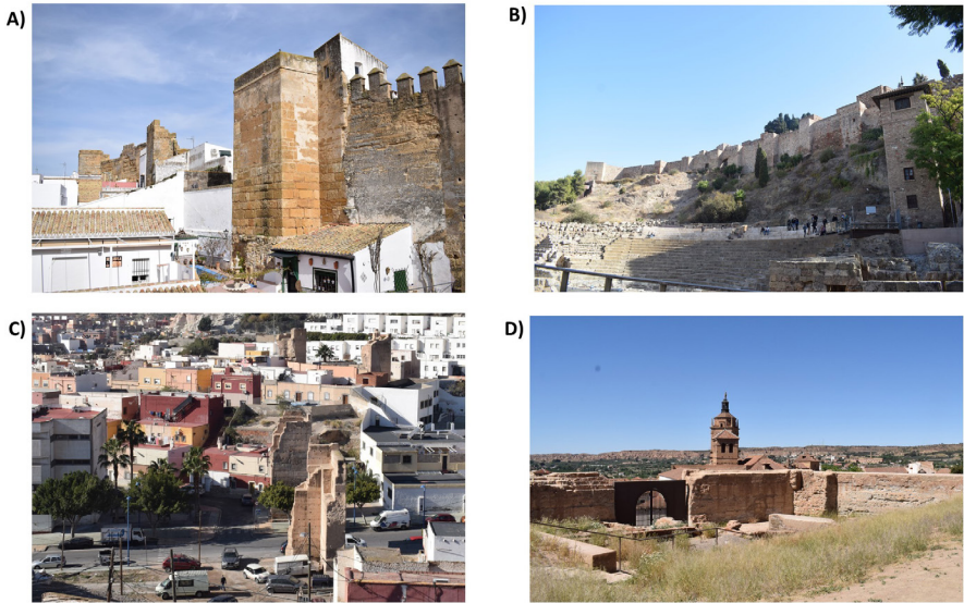
Figura 01. Ejemplos de municipios con fortificaciones en tapia conservadas en Andalucía. A) Carmona; B) Almería; C) Málaga y D) Guadix.
