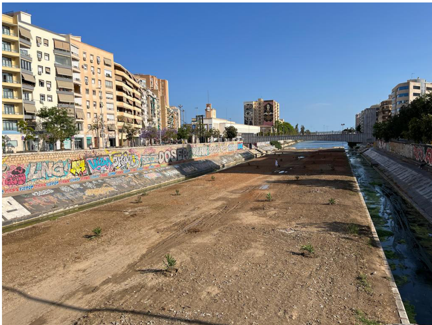
Figura 06. Trabajos de recuperación cauce Guadalmedina. Autora: Lourdes Royo (2023).
