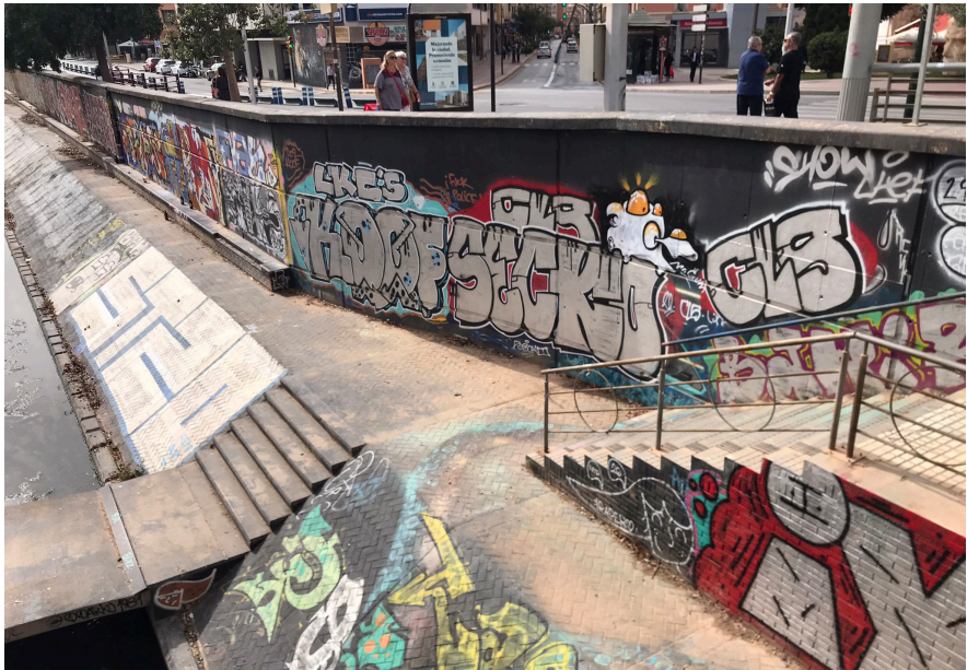
Figura 04. Cauce del Guadalmedina a su paso por el centro histórico. Autora: Lourdes Royo (2022).
