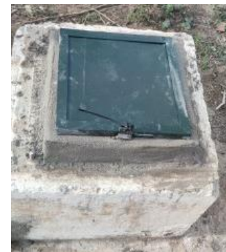
Sustitución de la caja.
