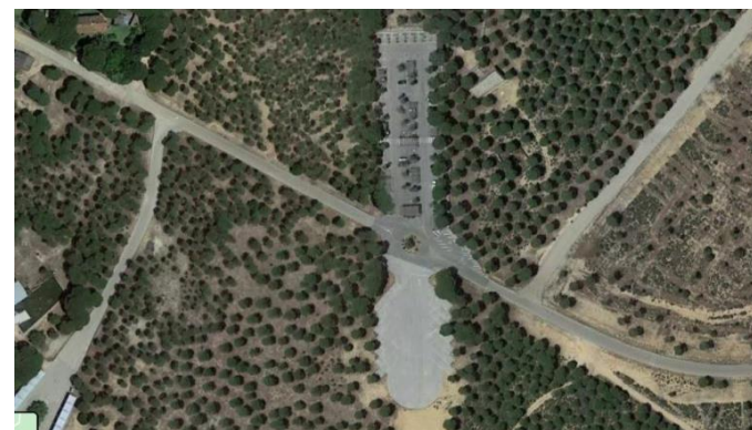
Vista aérea del aparcamiento del Centro de visitantes "El Acebuche". P.N. Doñana.
