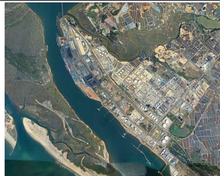
Vista aérea del Puerto Exterior de Huelva y P.I. Nuevo Puerto (Palos de la Frontera)
