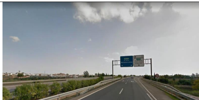
Vista de la A-483 con sección en autovía en las proximidades de Almonte
