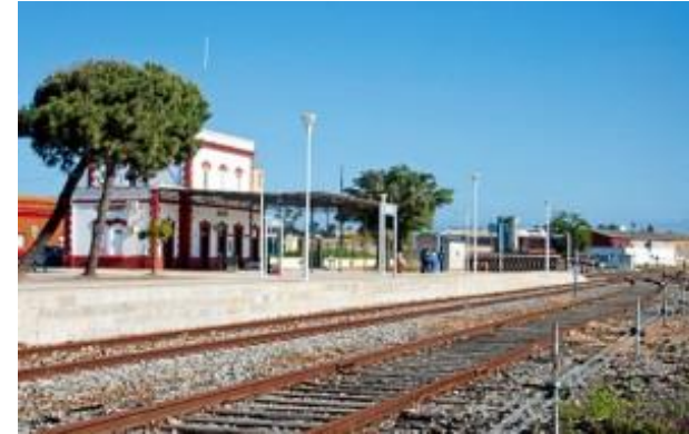
Ilustración 54: Estación ferroviaria de Gibraleón.
