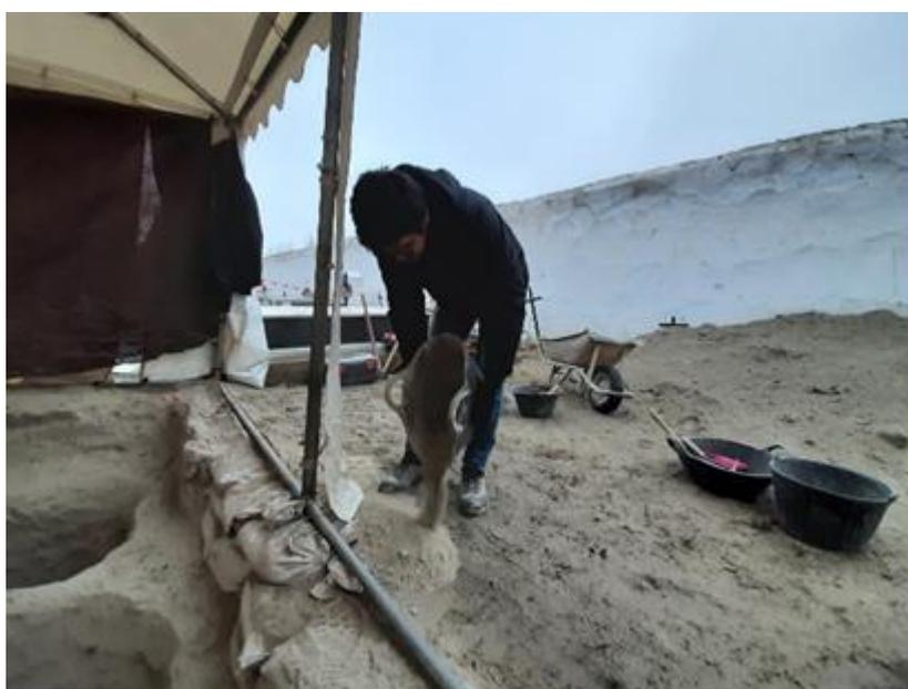
Figura 4.24.- Realización de caballones para evitar la entrada de agua en la zona de trabajo.
