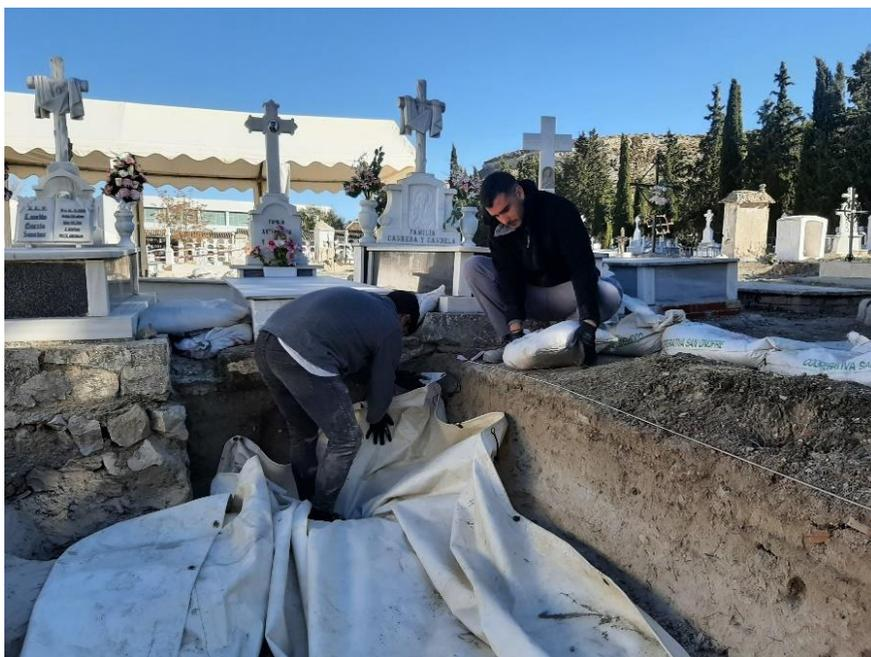
Figura 4.27.- Proceso de tapado con lonas y sacos terreros para evitar la entrada de aguas durante la noche.
