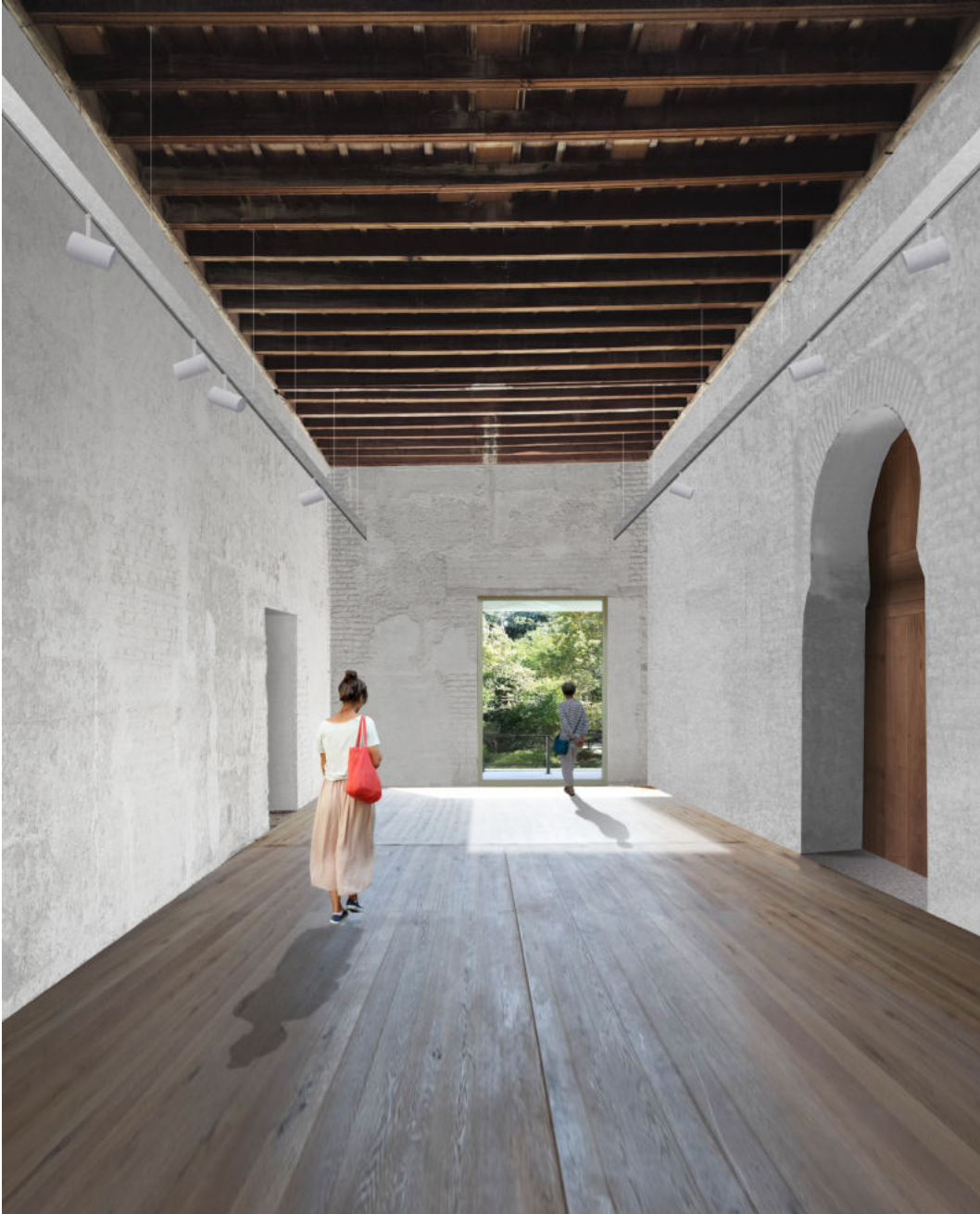
Vista de Taller-Seminario en la Sala Dormitorio Madre con recuperación de artesanado y revocos de mortero de cal.
