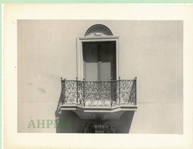
Uno de los balcones situados en la fachada del Teatro-Cine Albéniz AHPMa, FOT-134-2
