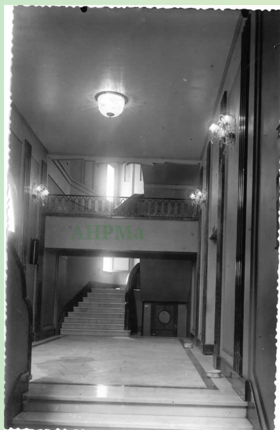
Vestíbulo y escaleras de acceso a la primera planta AHPMa, FOT-134-2
