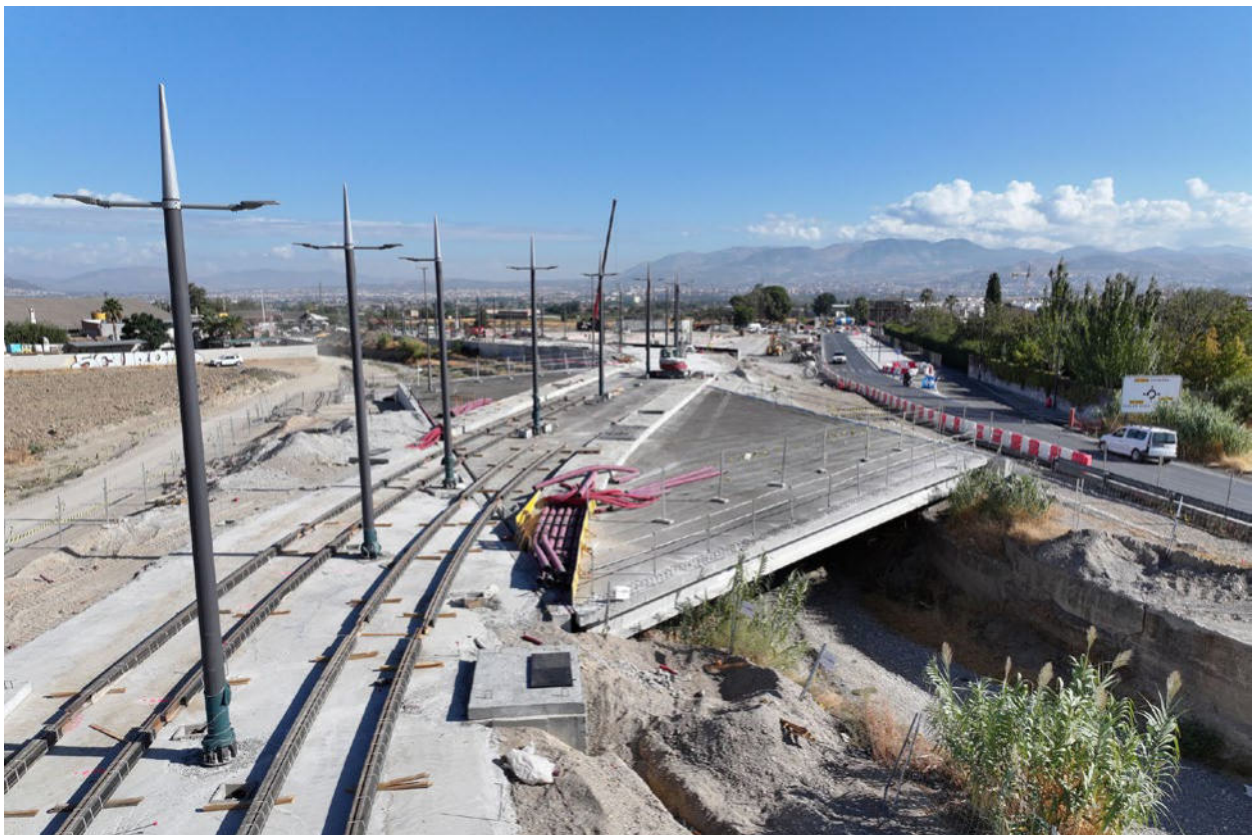
Estructura que salva el río Dilar que, además de las vías del metro, incorporará un carril bici, un paseo peatonal y una plaza mirador.
