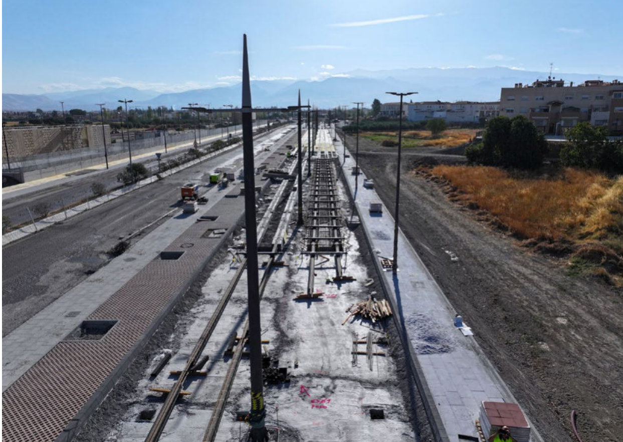
Trabajos en el Vial del Machuchón (a la izquierda, subestación eléctrica, inspirada en los secaderos de tabaco de la Vega).
